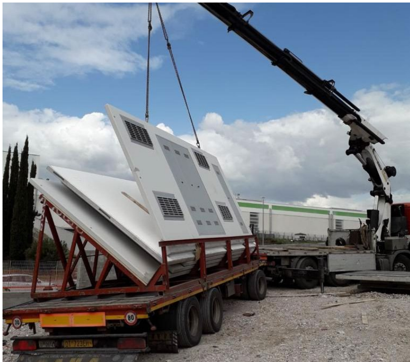
Figura 21 – Trasporto pannelli componibili cabine di trasformazione e di consegna
