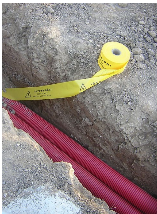
Figura 4 e 5 – Particolari di esecuzione della posa su scavo aperto
