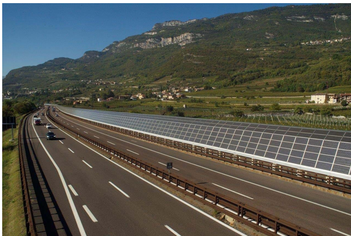
Figura 5 – Moduli fotovoltaici installati su una barriera antirumore e fonoassorbente da Autostrada del Brennero
