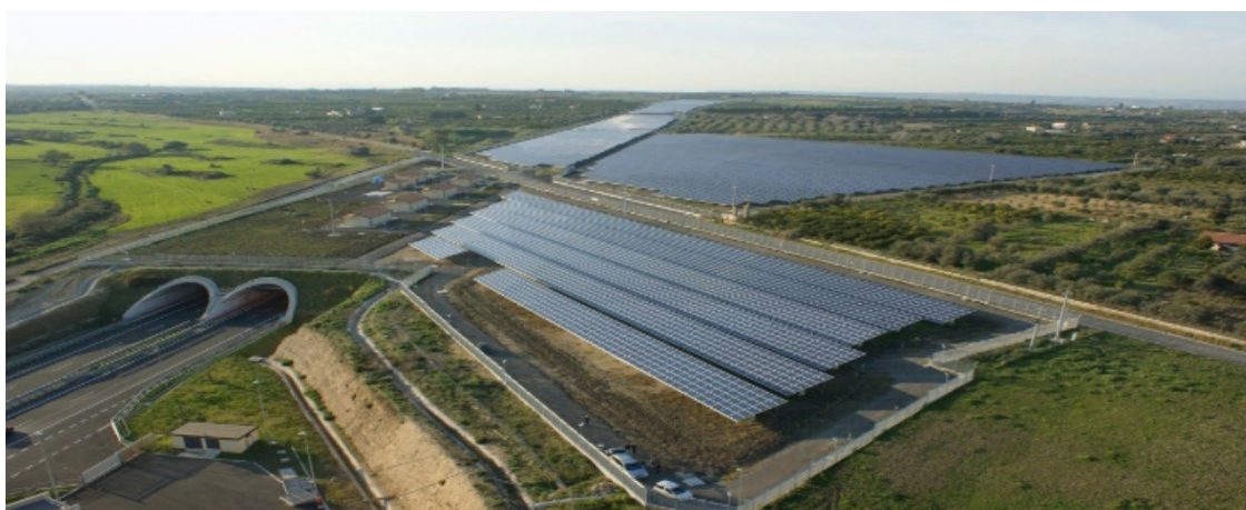
Figura 4 – Impianto fotovoltaico a terra ubicato al di sopra delle gallerie artificiali dell'Autostrada Catania-Siracusa
