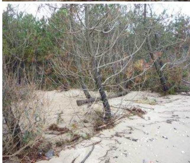
Figura 4.1 Immagini dopo la mareggiata del 31 gennaio 2014, prima dell'ultimo intervento di rinforzo: a) argine in terra a protezione della pineta fortemente eroso; b) argine in terra a protezione della pineta, nel tratto completamente eroso; c) particolare del tratto privo di argine di difesa e protezione della pineta; d) ingressione marina in pineta.
