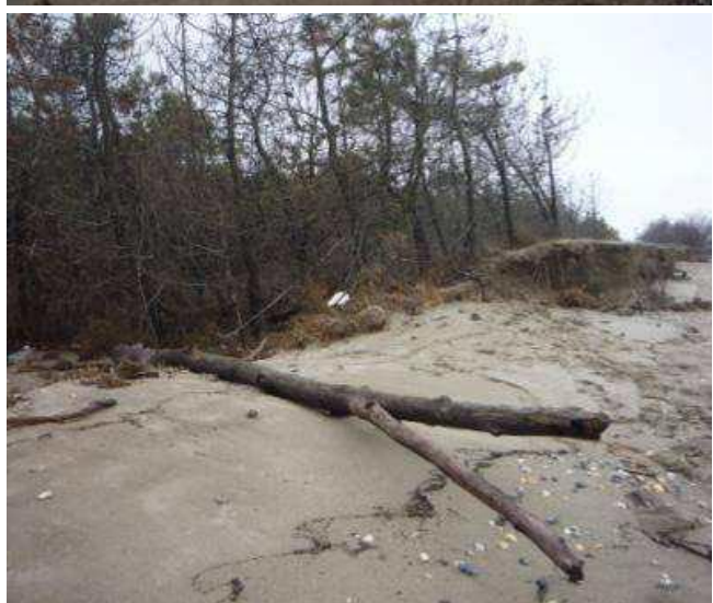
Figura 5.4 Immagini dopo la mareggiata del 31 gennaio 2014, prima dell'ultimo intervento di rinforzo: a) argine in terra a protezione della pineta fortemente eroso; b) argine in terra a protezione della pineta, nel tratto completamente eroso; c) particolare del tratto privo di argine di difesa e protezione della pineta; d) ingressione marina in pineta.
