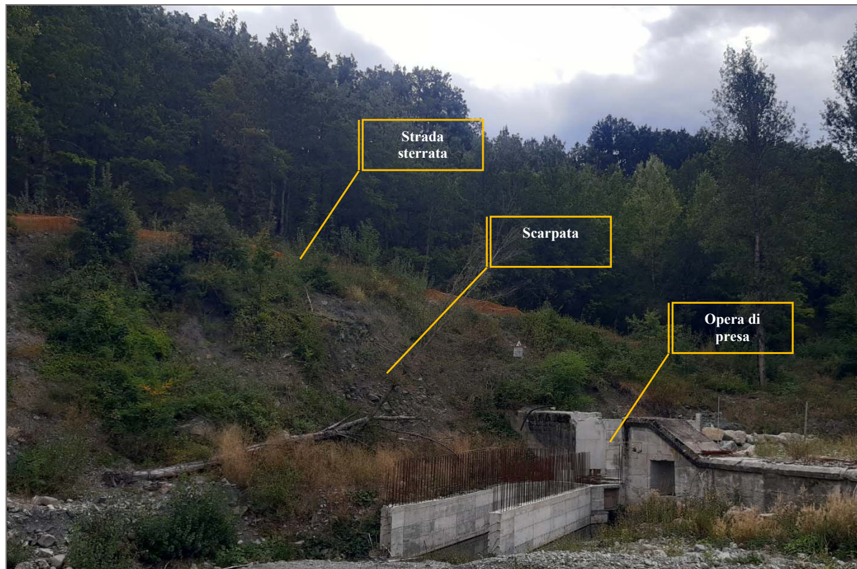
Foto 1: veduta del pendio oggetto di sistemazione mediante massi ciclopici (20/09/23) – Foto: Dott. Francesco Lelli
