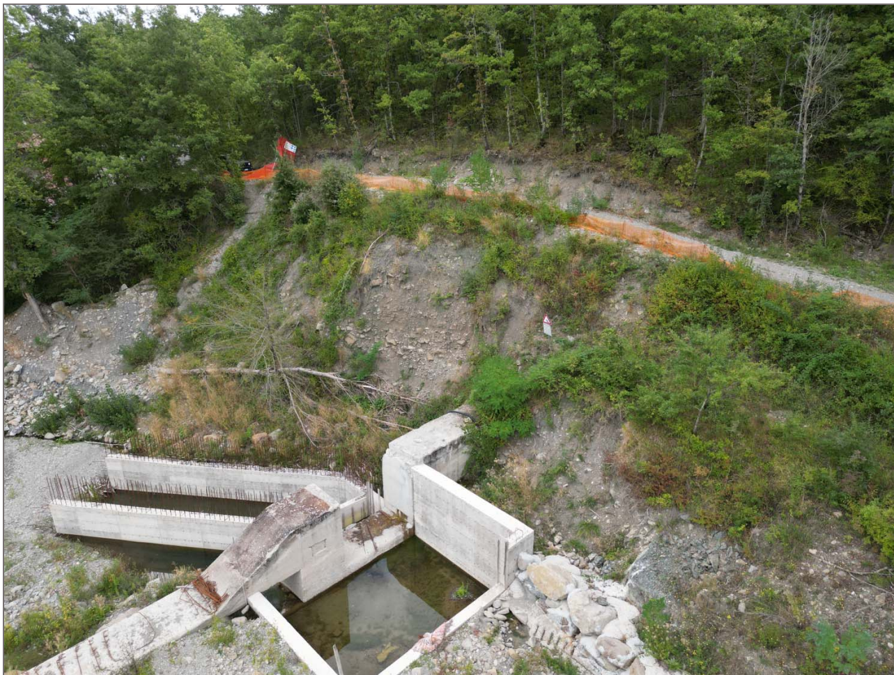
Foto 2: veduta del pendio oggetto di sistemazione mediante massi ciclopici (20/09/23) – Foto: Dott. Francesco Lelli
