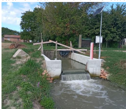
Figura 18- Stramazzo impianto Bastia
