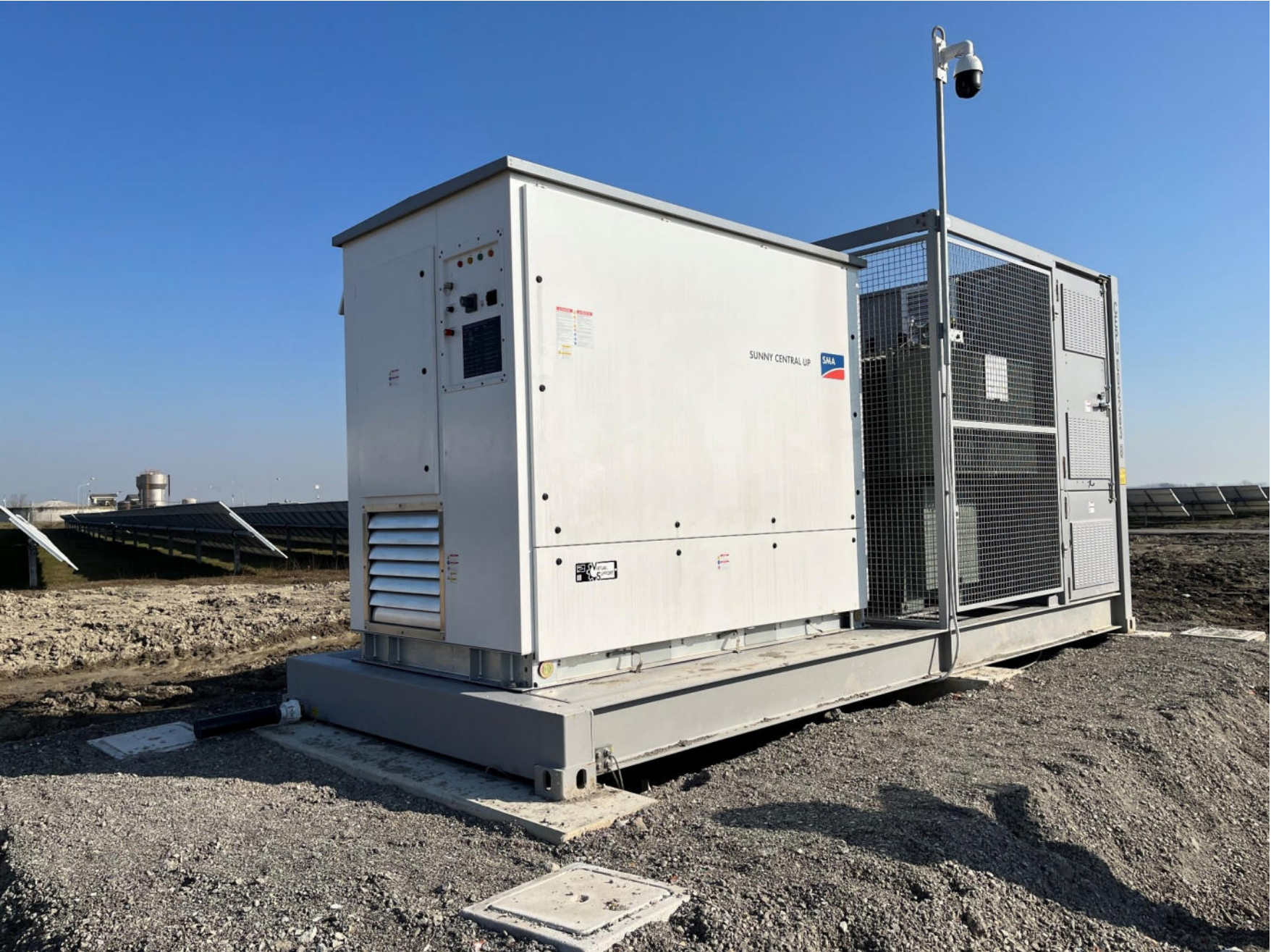
Figura 2: Esempio di posa in opera CU con dotazione di filtro tipo “Petro-Pipe” (ripresa in fase di allestimento dell’impianto).
