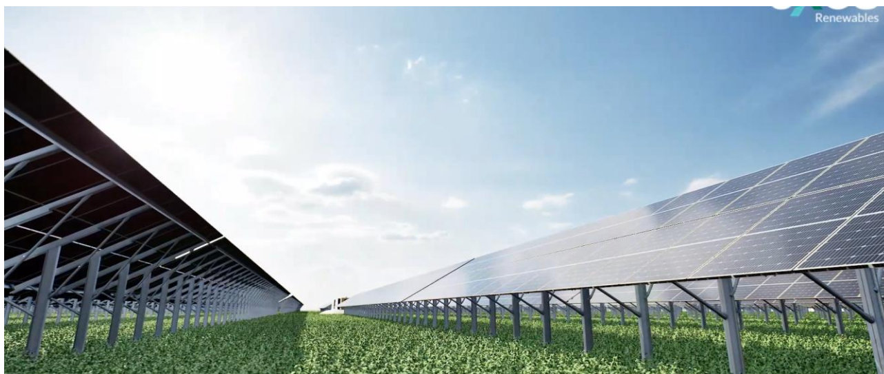
Figura 4-2: Struttura di sostegno dei moduli fotovoltaici
