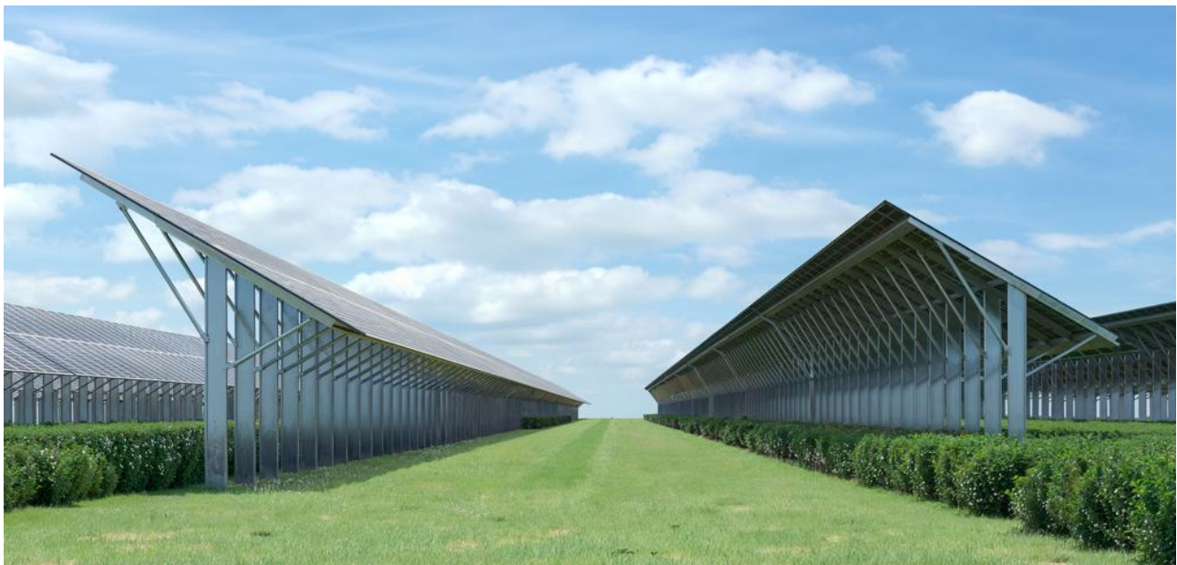
Figure 3-2: Render Struttura di sostegno
