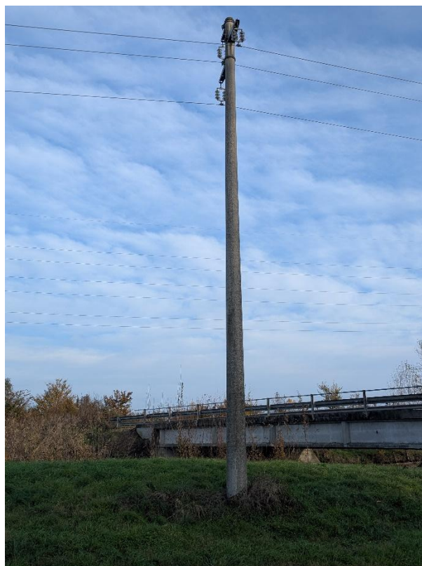
Figura 14 – Foto scattata in sito su linea elettrica aerea MT
