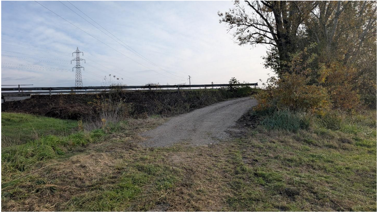
Figura 25 – Foto scattata in sito su strada di accesso da adeguare
