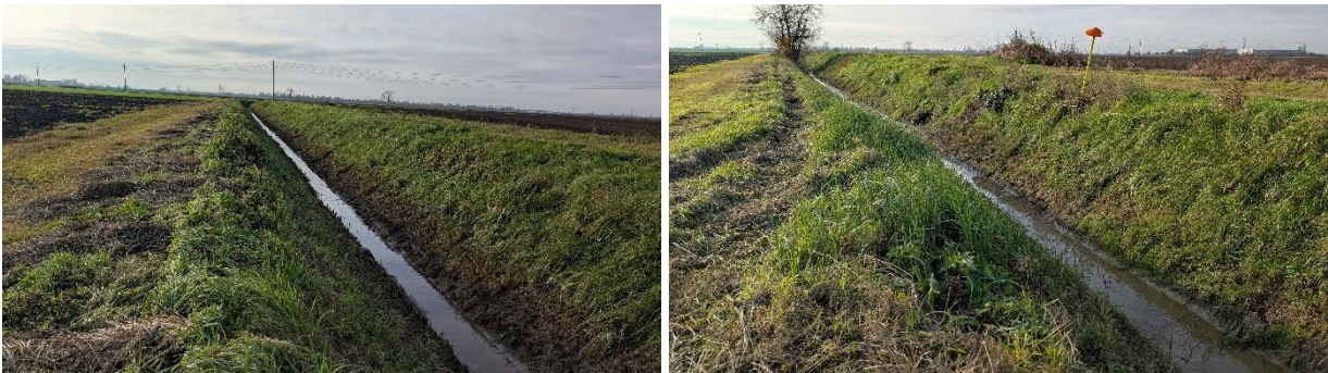
Figura 12 – Foto scattata in sito su canali di scolo.
