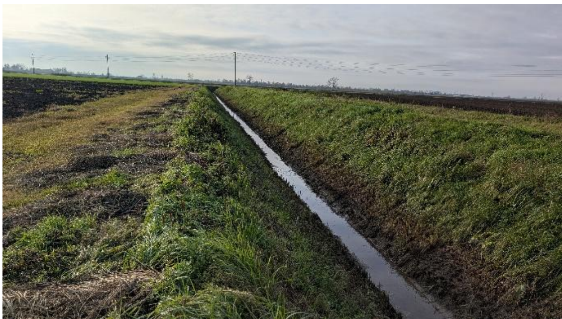
Figura 25 – Canale per l'irrigazione in ottimo stato di manutenzione con vegetazione erbacea sulle sponde
