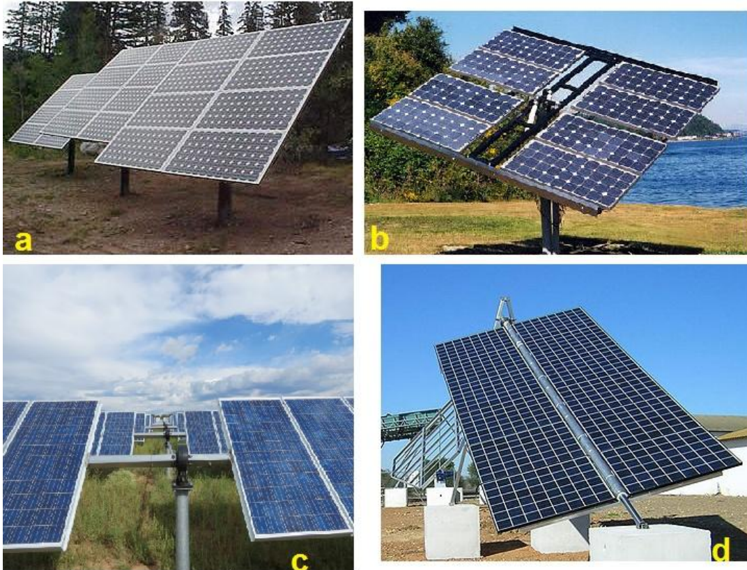
Figura 68 - Sistemi ad inseguimento: a) inseguitore di tilt, b) inseguitore di azimut, c) inseguitore di rollio, d) inseguitore ad asse polare.
