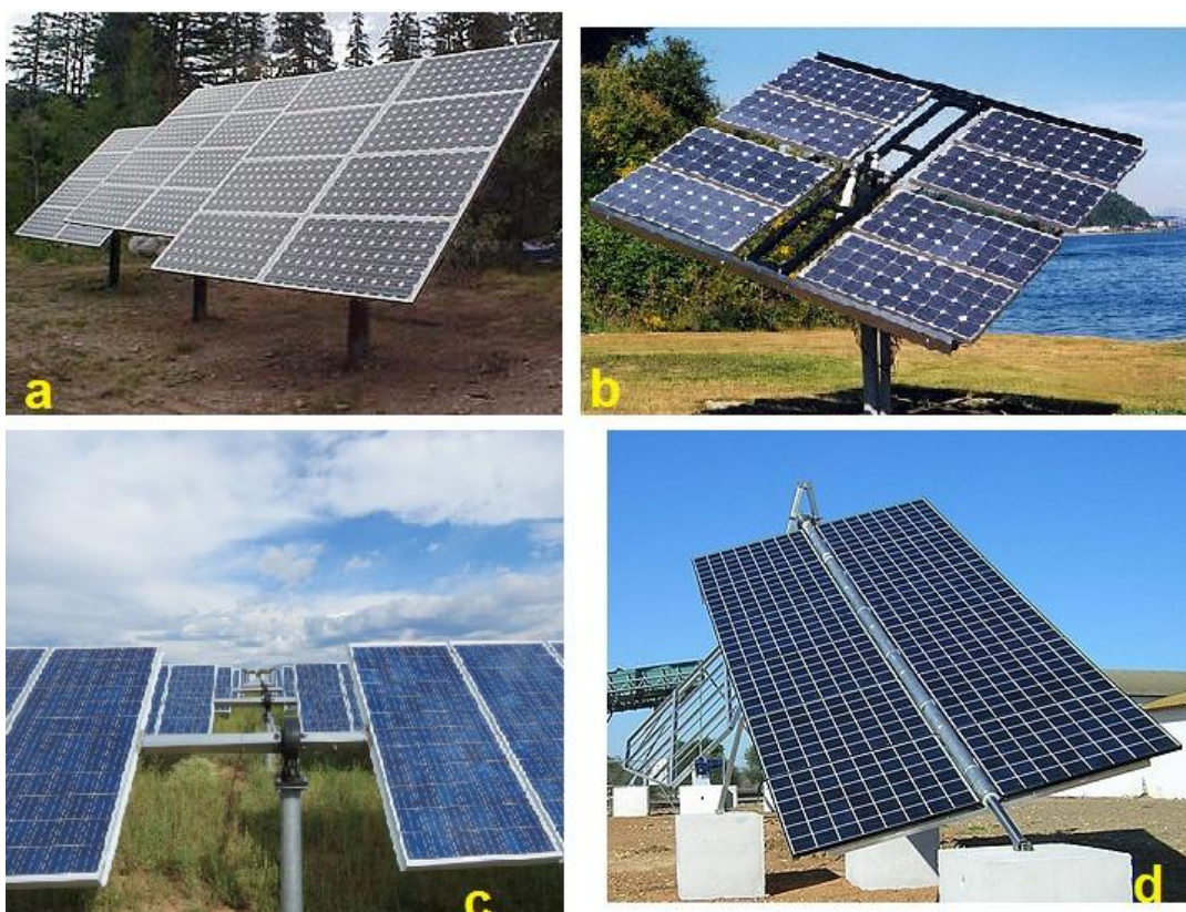
Figura 62 - Sistemi ad inseguimento: a) inseguitore di tilt, b) inseguitore di azimut, c) inseguitore di rollio, d) inseguitore ad asse polare.
