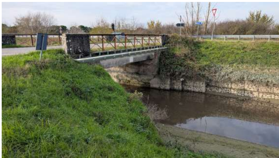
Foto 1 - Attraversamento Fossa Raso e Tresinario Vecchio – post-operam
