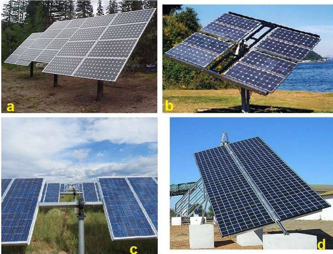
Figura 3 - Sistemi ad inseguimento: a) inseguitore di tilt, b) inseguitore di azimuth, c) inseguitore di rollio, d) inseguitore ad asse polare.
