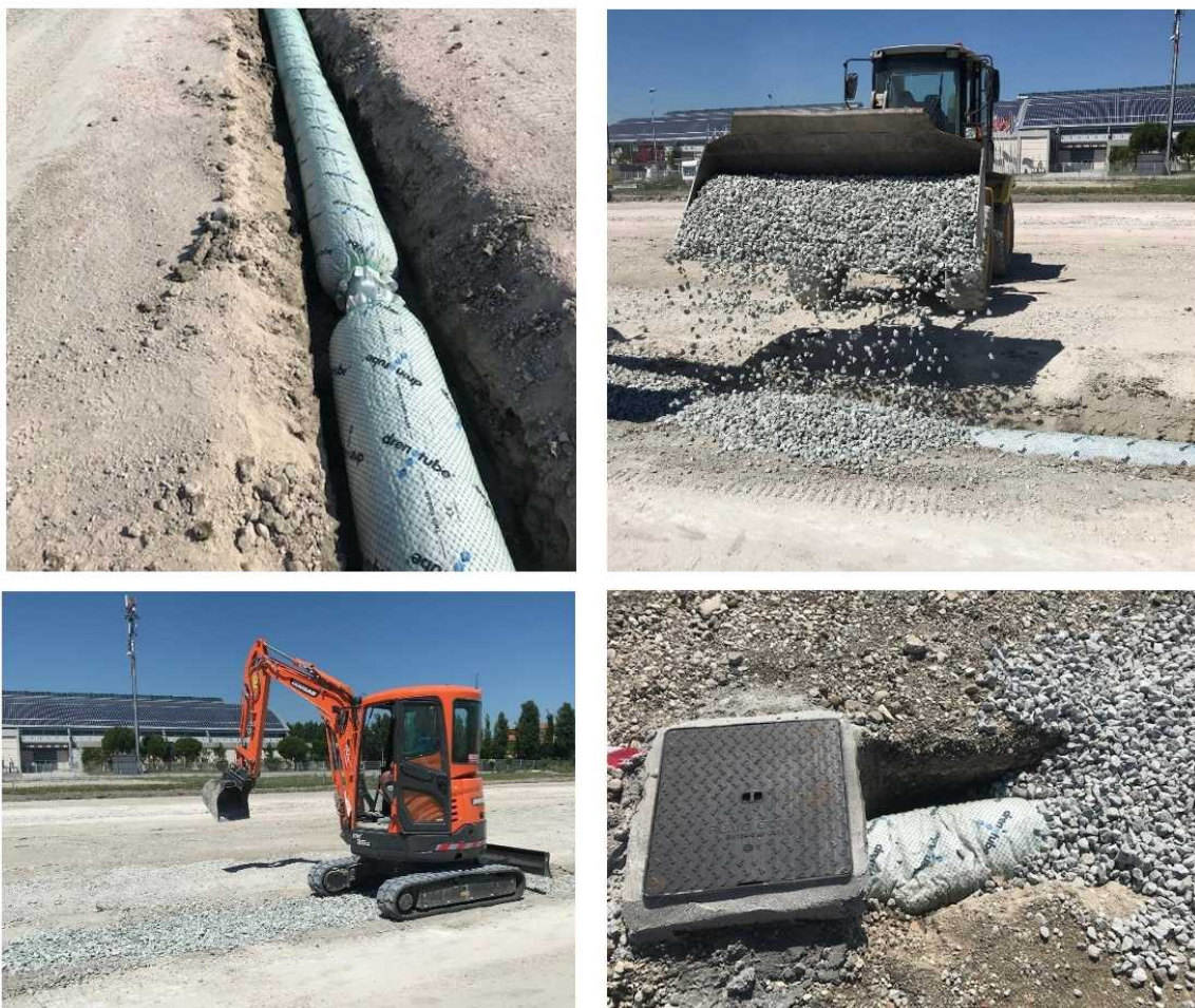
Figura 5 – Fasi di lavorazione per la realizzazione di una trincea drenante
