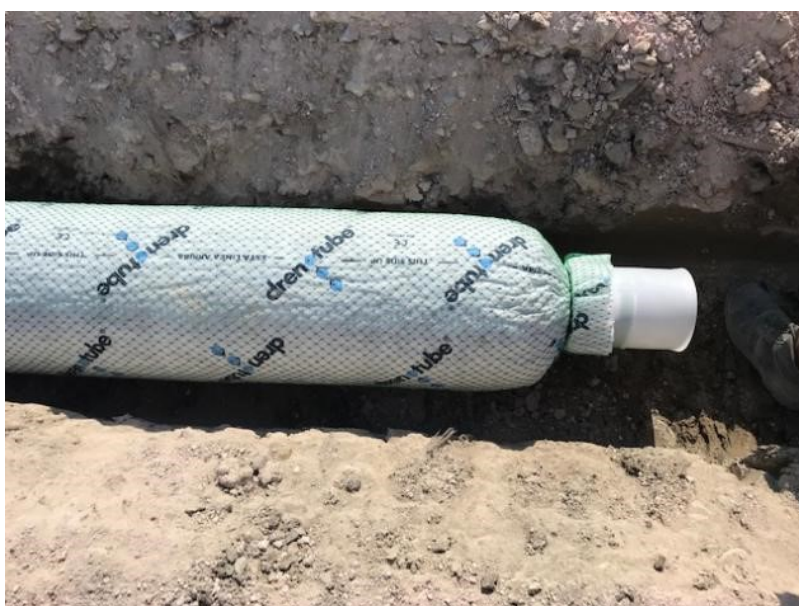
Figura 4 – Dettaglio di una tipologia di tubo di drenaggio
