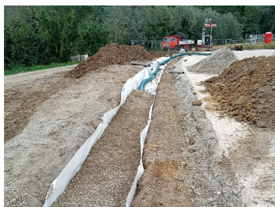
Figura 3 – Fasi di realizzazione delle trincee drenanti nel sito di Monte Coralli
