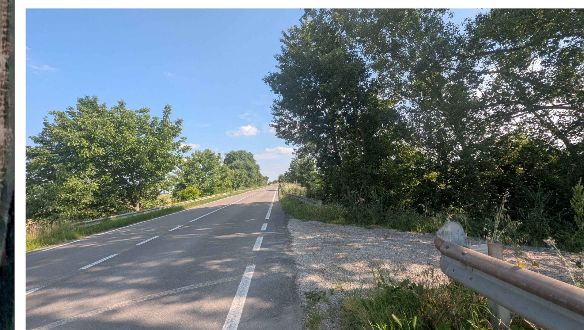
FOTO ACCESSO DA SP46
