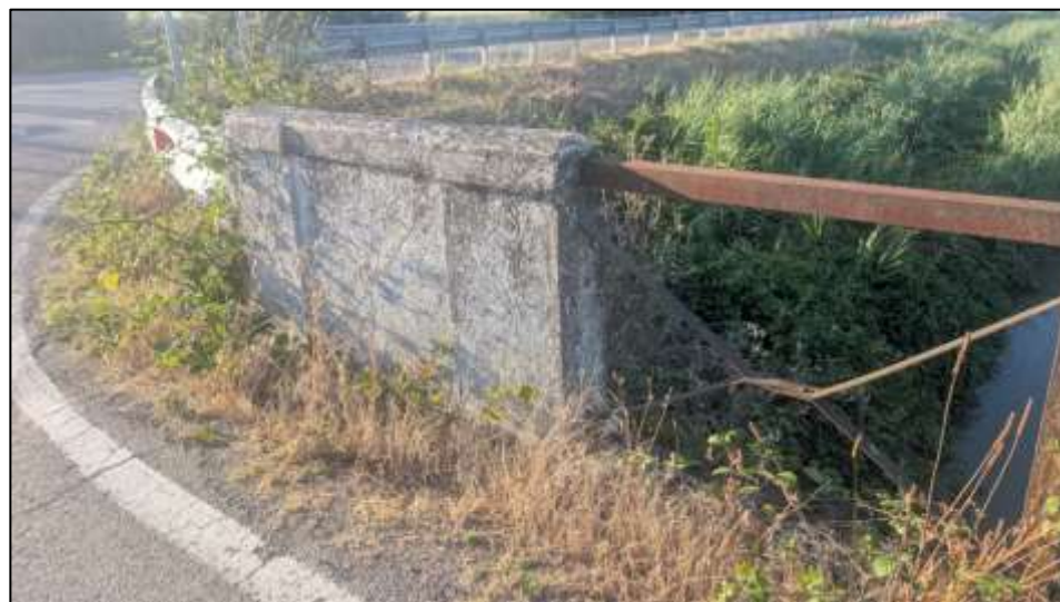
Figura 13: Foto del ponte – Dettaglio 3
