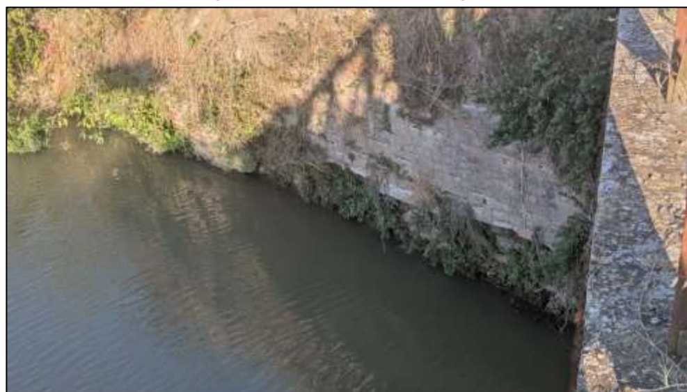
Figura 12: Foto del ponte – Dettaglio 2
