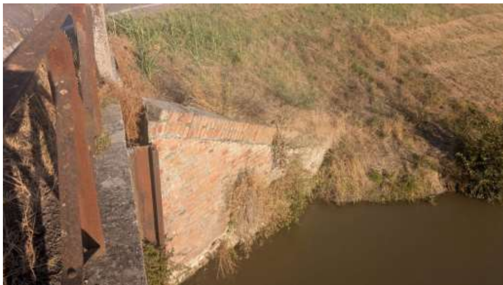
Figura 11: Foto del ponte – Dettaglio 1
