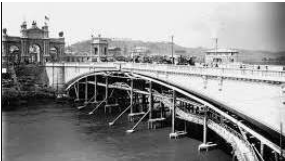
Figura 16: Ponte Risorgimento in fase di realizzazione
