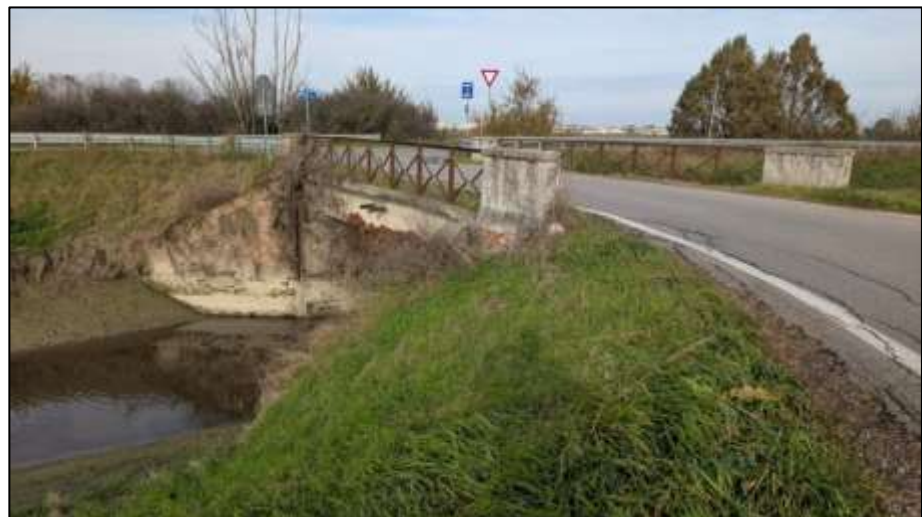
Figura 10: Foto del ponte da Via Argine Canale
