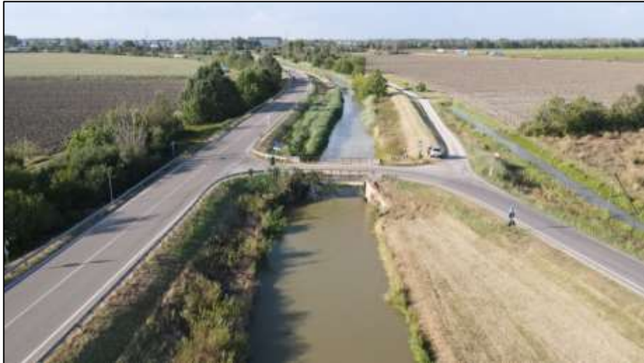
Figura 8: Foto del ponte in direzione Nord
