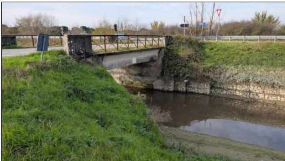
Figura 9: Foto del ponte da Via Argine Canale
