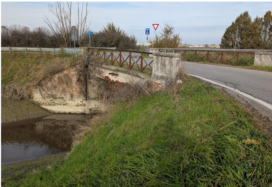
Figura 11 – Foto scattata in sito su ponte esistente
