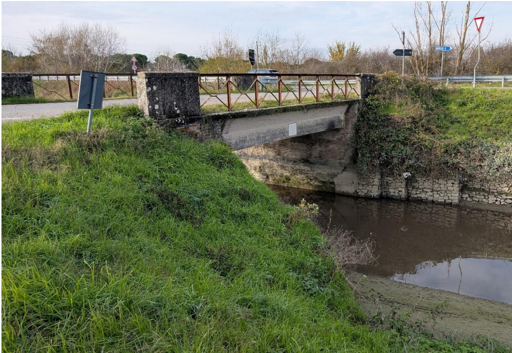
Figura 10 – Foto scattata in sito su ponte esistente
