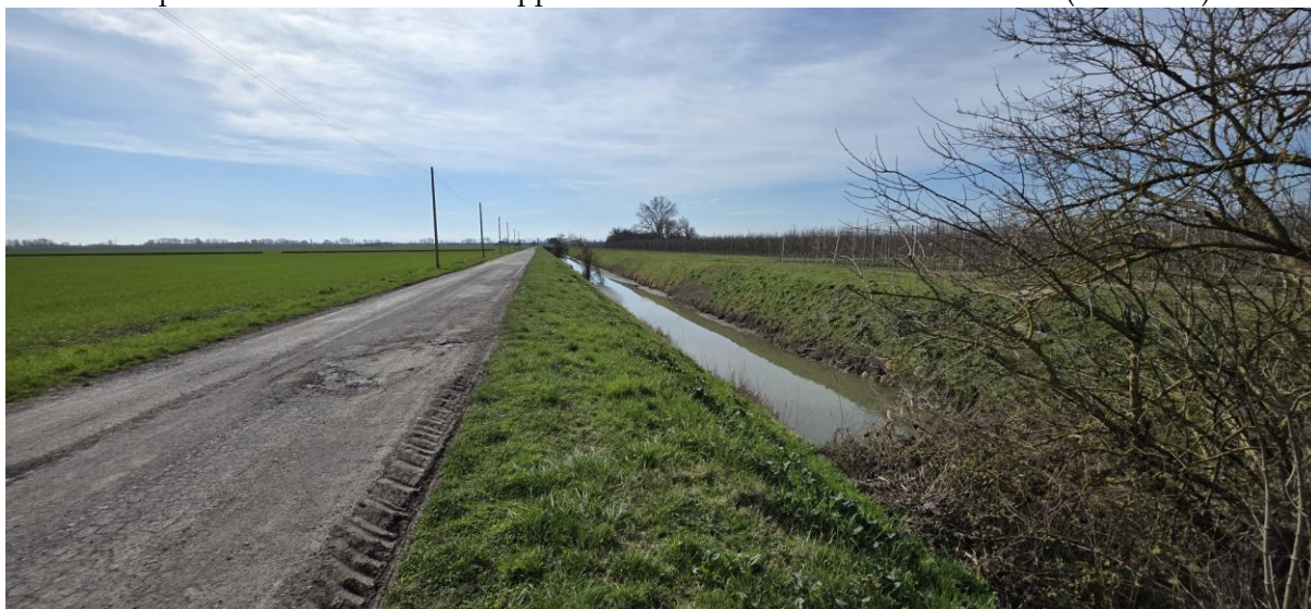
Foto 2 Via Spina - sede stradale di sviluppo del tracciato del cavidotto - tratto E-F (dirz. SUD)
