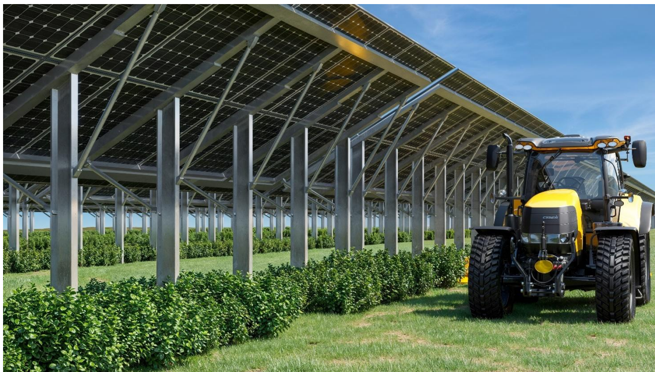
Figure 3-3: Struttura di sostegno e passaggio trattore
