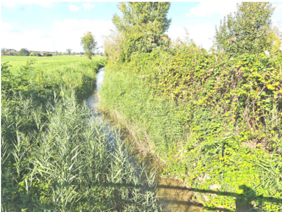
Vista verso nord del Canalazzo in prossimità del vertice nord-orientale del lago L1 (nodo Q)
