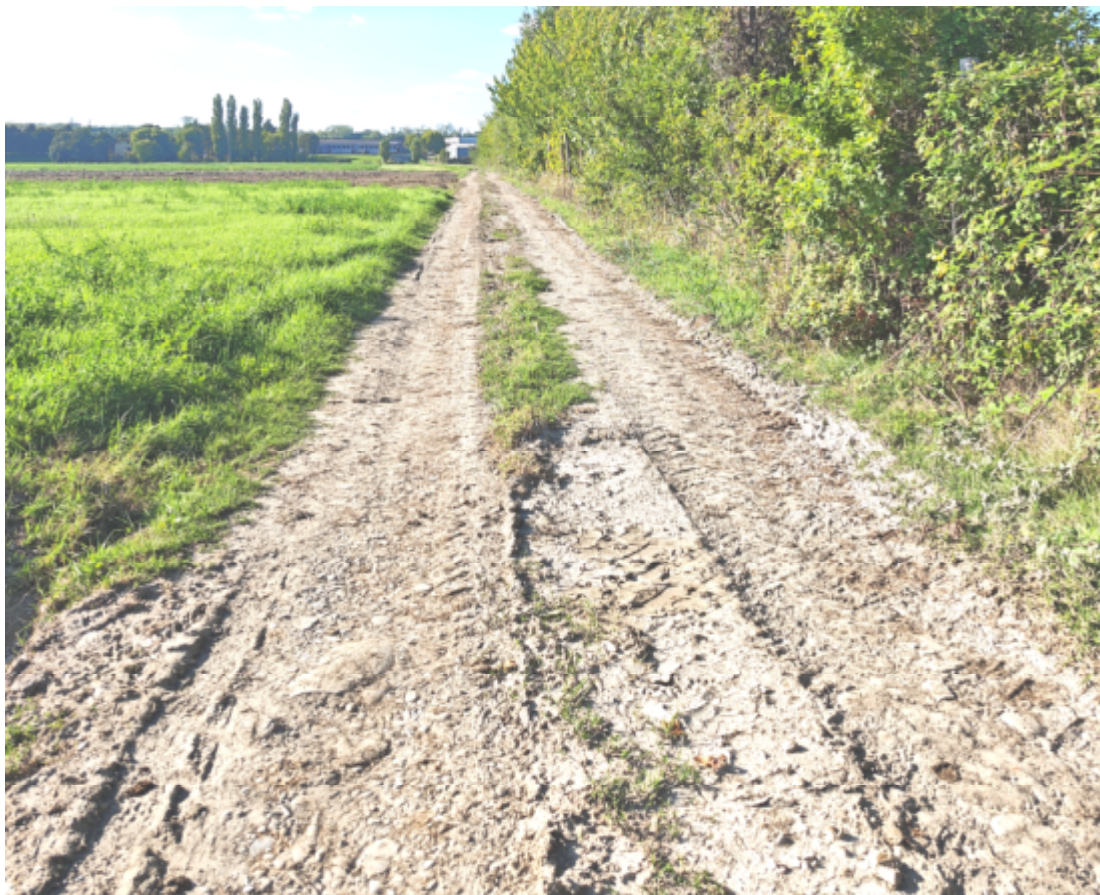
Vista verso ovest del tracciato della condotta interrata, di adduzione dal Canalazzo con rilascio a lago L3, posta sotto lo sterrato da sistemare insieme al fosso (in sinistra) e della ricostruzione della recinzione (a destra) (tratto nodi B-D)
