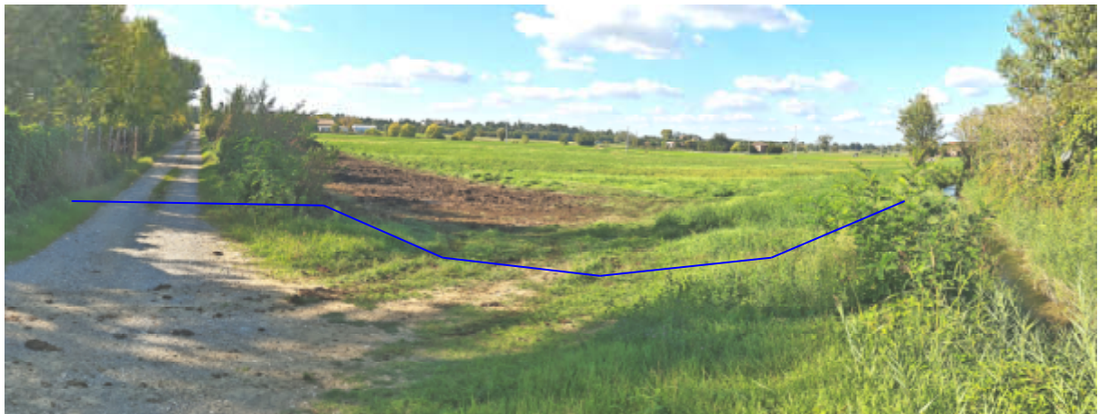
Vista panoramica dal vertice nord-orientale del lago L1, da direzione ovest a nord, con vista della strada perimetrale nord, Canalazzo e posizione della condotta interrata per il rilascio delle acque invase in L1 nel Canalazzo (tratto I-L-M-N)
