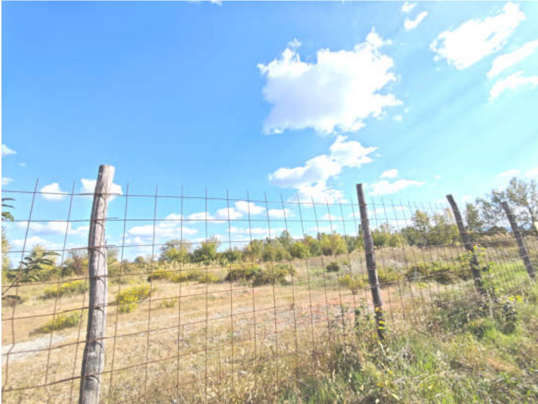
Vista verso est, in sponda ovest del lago L1, della recinzione da sostituire
