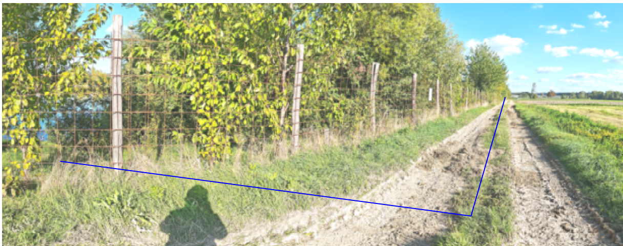
Vista panoramica dal vertice sud-est del lago L3, da direzione nord a est, con vista della zona di passaggio finale della condotta interrata in arrivo al lago L3 e della strada perimetrale sud sotto cui passa la condotta (tratto C-D-E)
