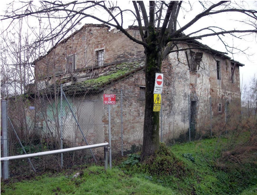
Foto 5 – Prospetto lato via Cerchia
