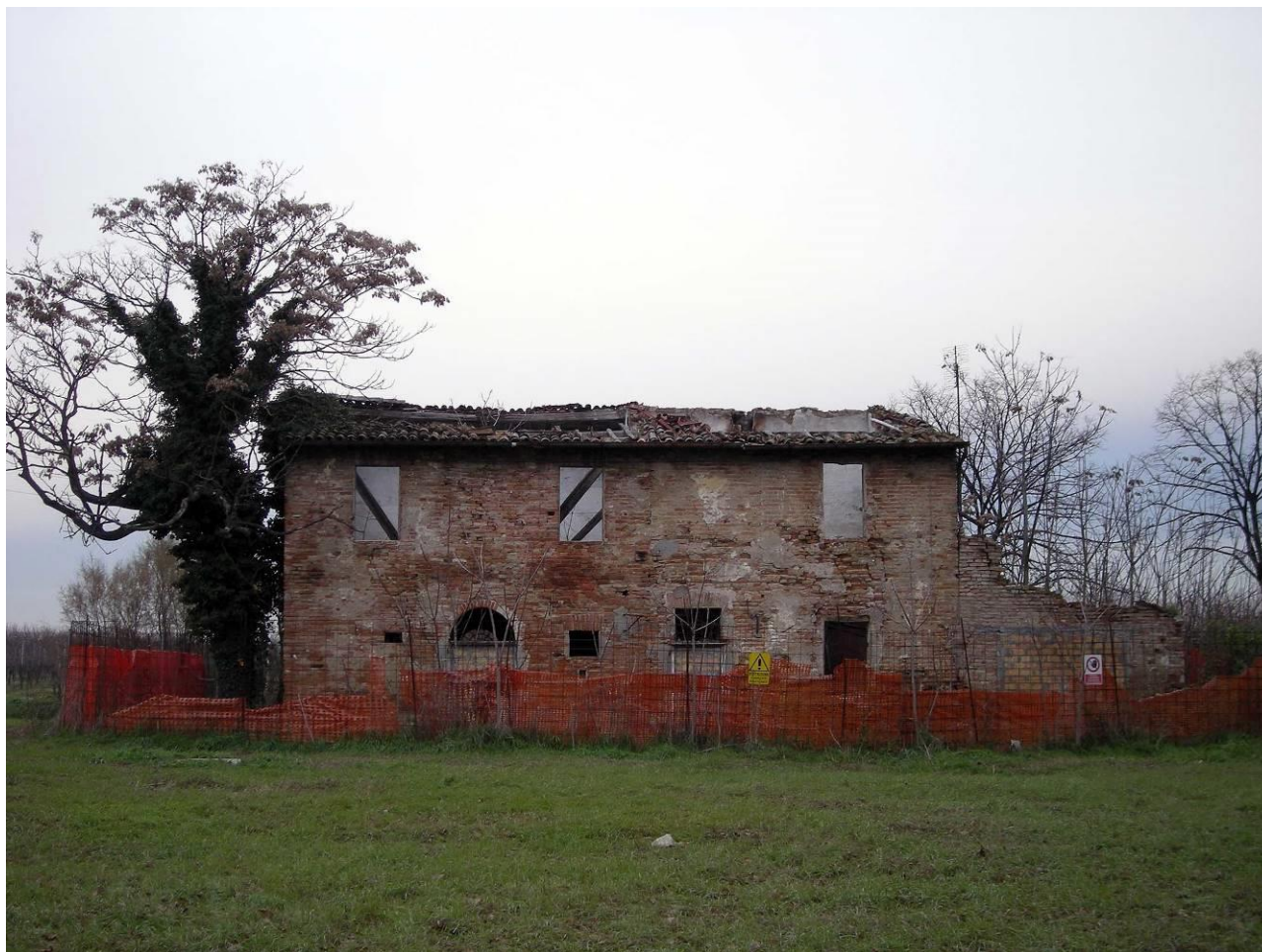
Foto 4 – Prospetto lato Caviro
