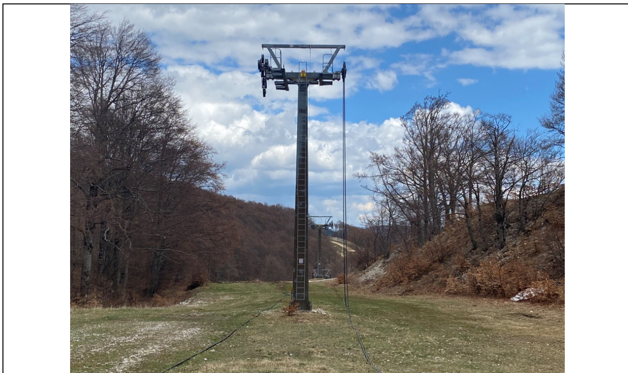
Foto 2 smontaggio fune portante traente su seggiovia triposto
