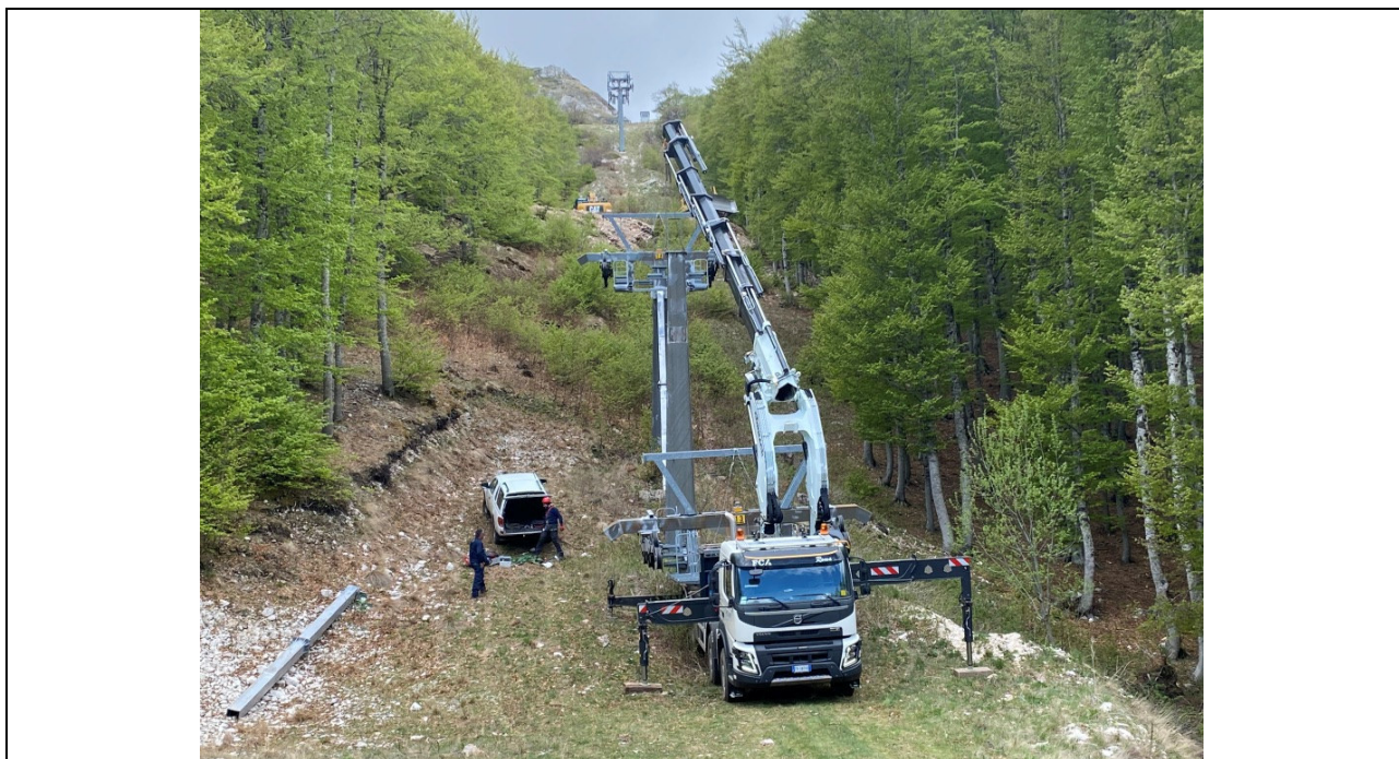
Foto 3 Smontaggio delle testate dei sostegni di una seggiovia
