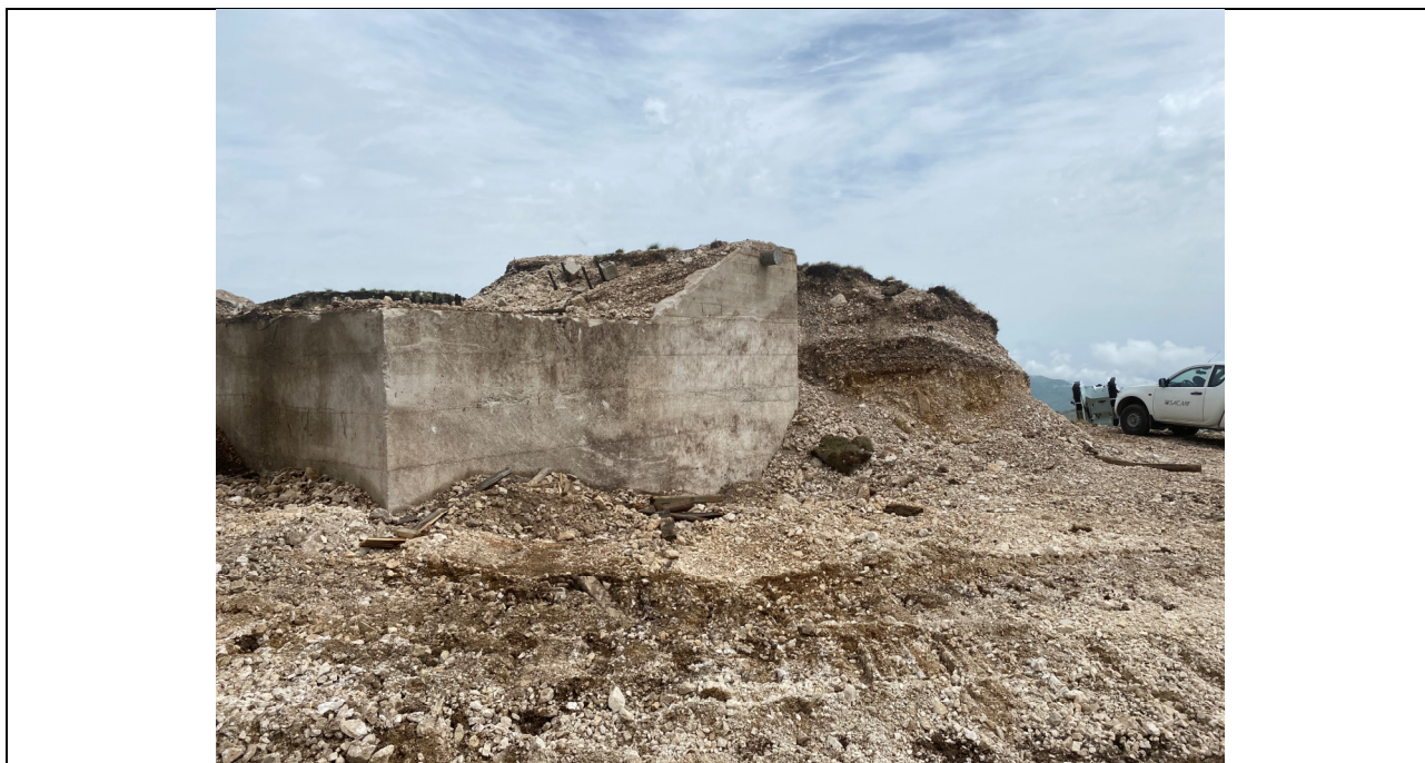
Foto 7 Manufatto di fondazione da demolire con relativi tirafondi (stazione rinvio seggiovia)
