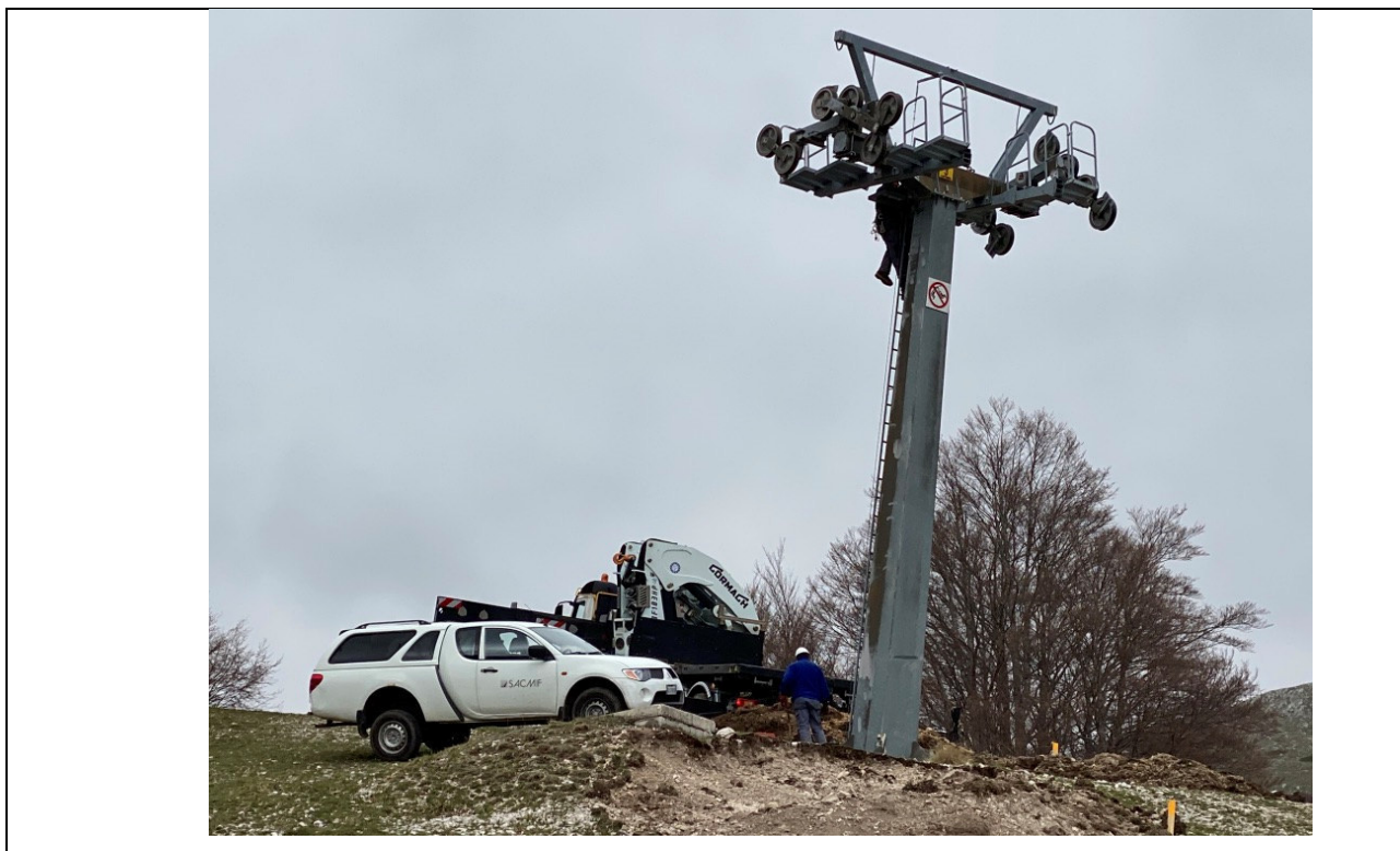
Foto 4 Smontaggio delle testate dei sostegni di una seggiovia
