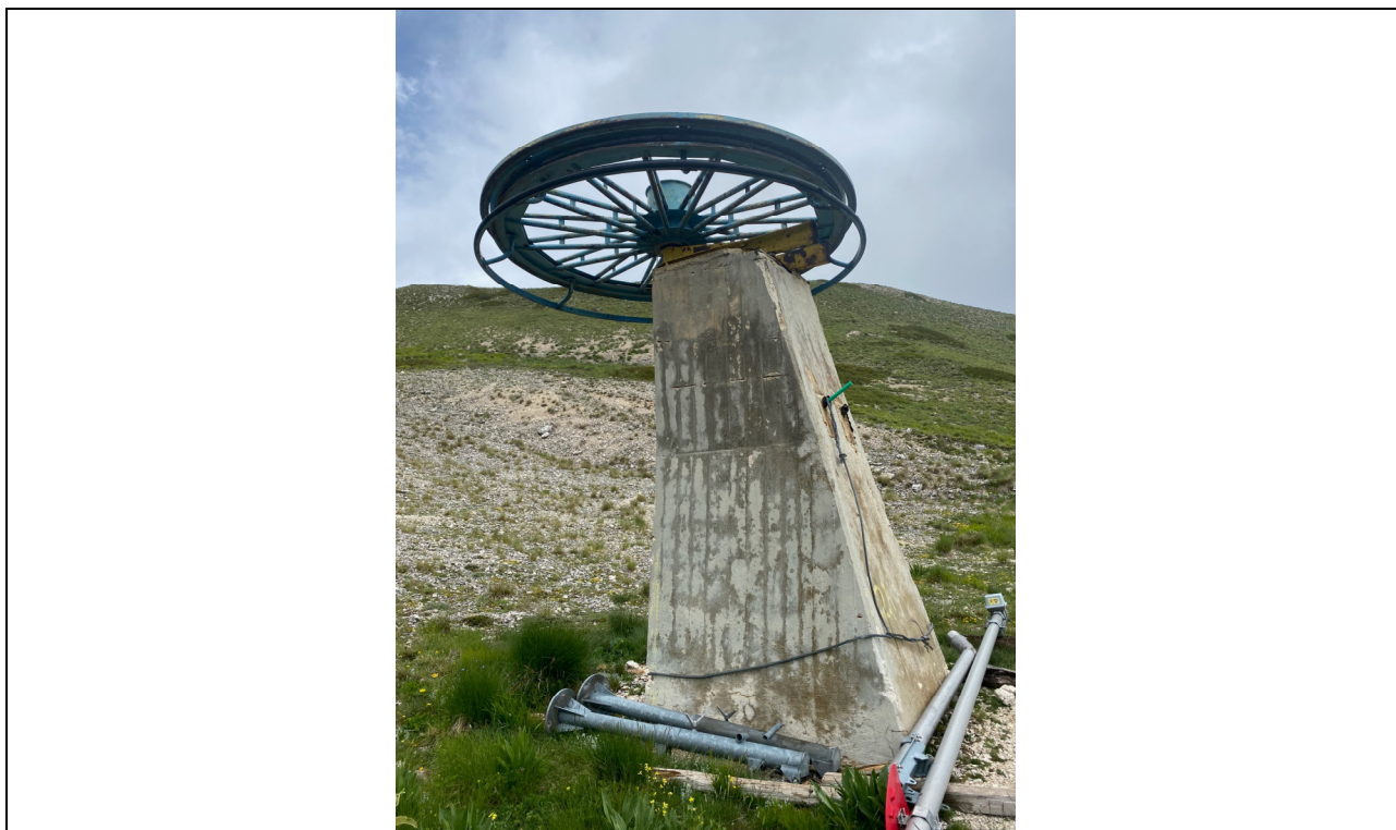
Foto 8 Manufatto di elevazione in cls di una sciovia
