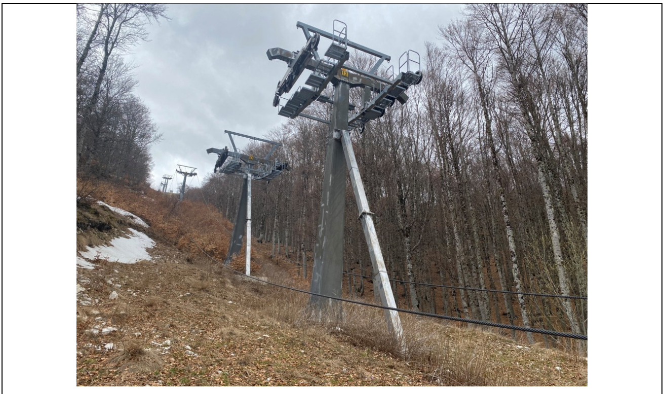
Foto 1 smontaggio fune portante traente su seggiovia triposto
