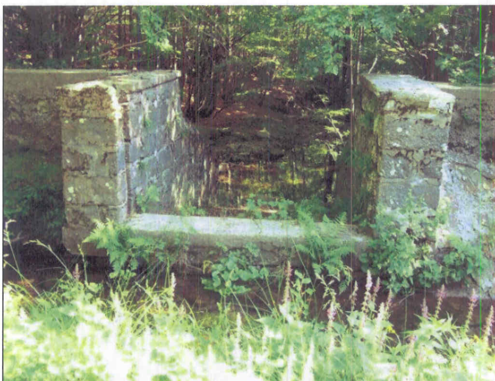
Presa Rio Garzoli – Luce di sfioro panconabile posta nella mezzeria dello sfioratore dal versante lato presa
