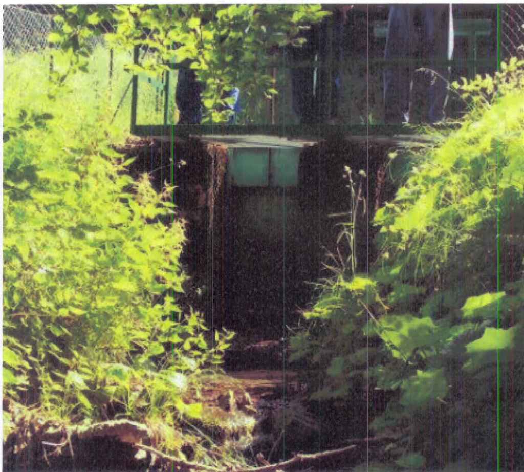
Presa Rio Borellacci – Vista da valle della piccola briglia dotata di due paratoie di scarico
