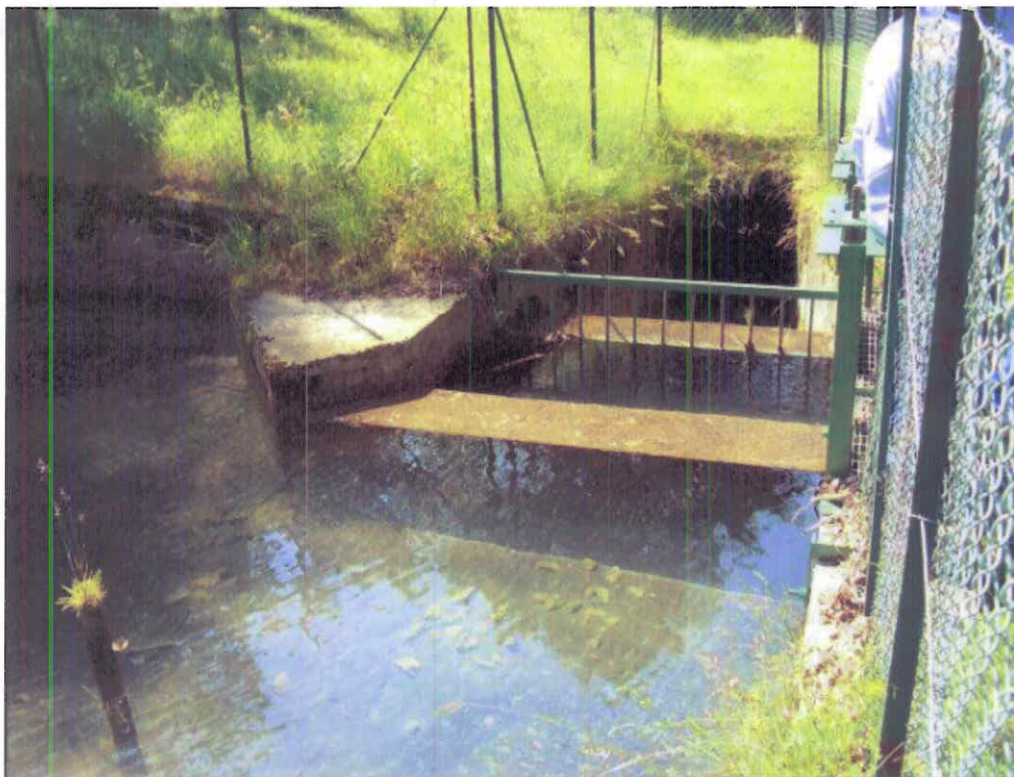
Presa Rio Borellacci – Vasca di raccolta in primo piano - Vista, sullo sfondo, del canale derivatore, preceduto dalla piccola vasca di decantazione
