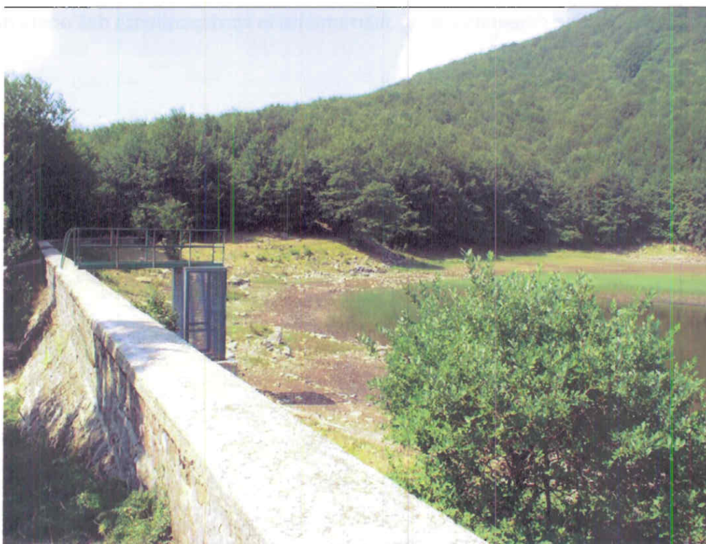
Lago Squincio - Vista del paramento di valle, e della sponda sinistra del bacino. Sullo sfondo la passerella di collegamento tra il coronamento e l'opera di presa
