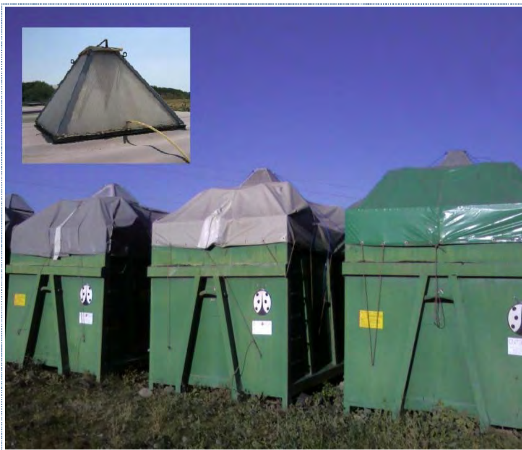
Esempi di biofiltri per la bioossidazione del metano di una discarica piemontese; dettaglio della cappa di emissione del gas depurato
