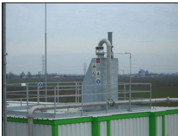
Fig.14.: Valvola di sicurezza sul tetto del fermentatore primario
