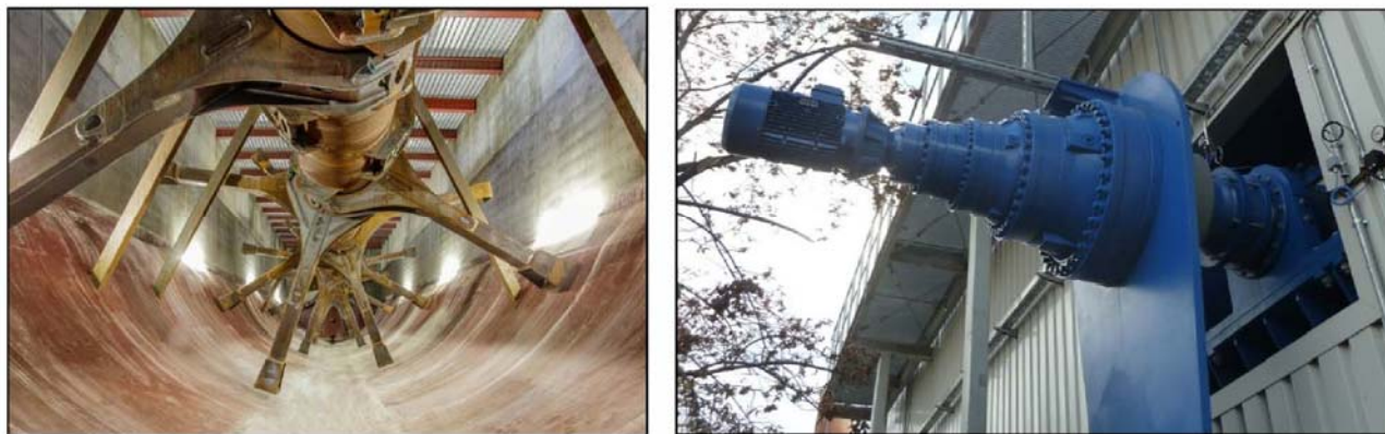
Fig.17.: Particolari degli organi di movimentazione interni del digestore, di tipo longitudinale (in alto) o trasversale (in basso), a seconda del costruttore
