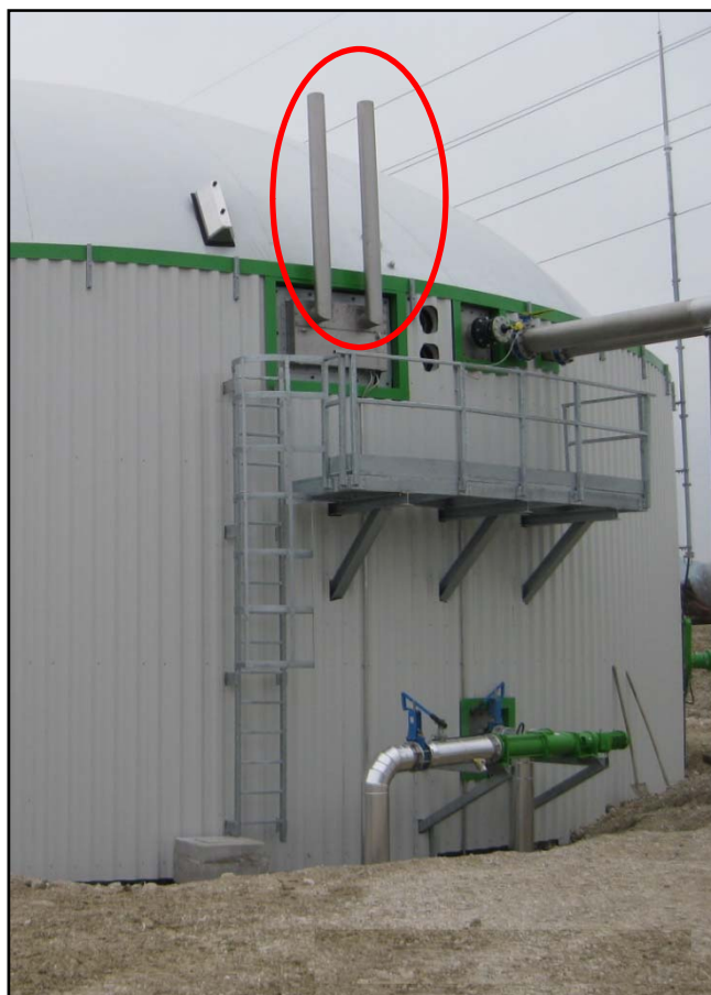
Fig.21.: Il cerchio rosso identifica i camini delle due valvole di sicurezza
