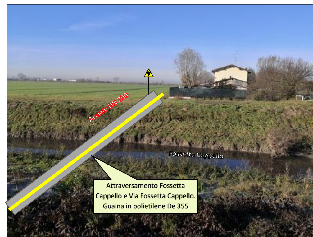
Fotografia 56: Attraversamento su Fossetta Cappello
