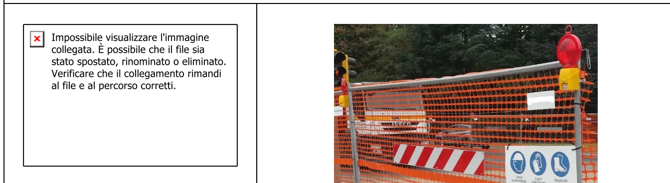
fig. 4.2 – barriere di CLS con soprastanti rete di recinzione e lampade di sicurezza rosse
