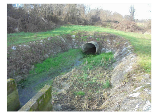
7 - VASCA DI DISSIPAZIONE E CANALETTA A CIELO APERTO DI VALLE
