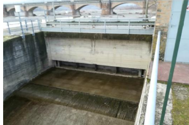
FIGURA 2-4: OPERA DI PRESA CON VISTA DELLA TRAVERSA MOBILE E DELLA GRIGLIA DI DERIVAZIONE DI FONDO
