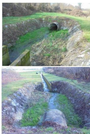
FIGURA 2-14: VASCA DI DISSIPAZIONE DELLA CORRENTE IN ARRIVO DALLA CONDOTTA DI MEDESANO E CANALETTA DIRETTA AL CANALAZZO
