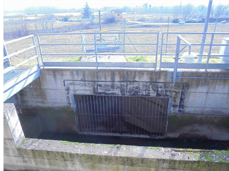
2- GRIGLIA ALL'IMBOCCO DELLA CONDOTTA DI MEDESANO
