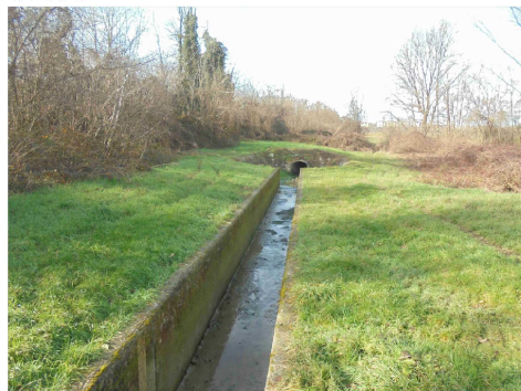
5 - CANALETTA A CIELO APERTO CON SEZIONE IN C.A.
