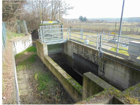
2- GRIGLIA ALL'IMBOCCO DELLA CONDOTTA DI MEDESANO
