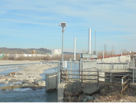
11 - CANALE DI DERIVAZIONE DELLE PORTATE DELLA CENTRALE IDROELETTRICA IN DESTRA TARO
