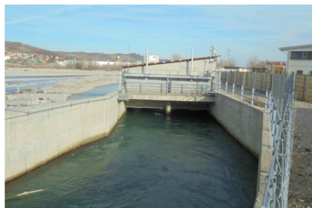
FIGURA 2-9: CANALE DI DERIVAZIONE DELLE PORTATE DELLA CENTRALE IDROELETTRICA IN DESTRA TARO (FOTO 11)
