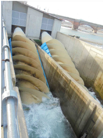
12 - VISTA DELLE DUE COCLEE DELLA CENTRALE IDROELETTRICA IN DESTRA TARO
