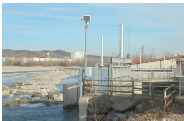
FIGURA 2-8: CENTRALINA IDROELETTRICA IN DESTRA TARO CON VISTA DELLA SCALA DI RISALITA DEI PESCI (FOTO 10)
