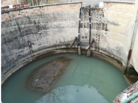
9 - SISTEMA DI SOLLEVAMENTO DELLE ACQUE AD USO POTABILE COSTITUITO DA DUE POMPE SOMMERSE IN GESTIONE AD ATERSIR
