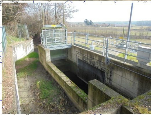
F3 - Imbocco manufatto su canale del Duca con vista della derivazione lungo la condotta di Medesano che alimenta oltre al canale Canalazzo, anche la centrale idroelettrica di progetto e i bacini irrigui in fase di realizzazione.
