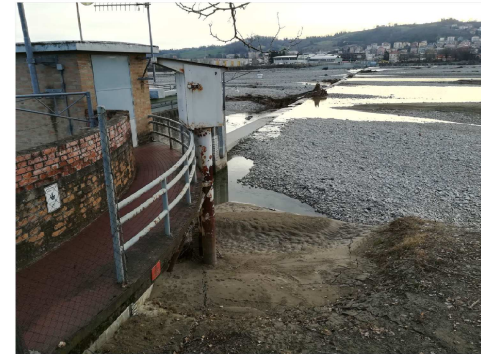
4 - OPERA DI PRESA CON VISTA DELLA DELLA TRAVERSA MOBILE E DELLA GRIGLIA DI DERIVAZIONE DI FONDO
