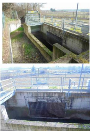
FIGURA 2-13: OPERA DI DERIVAZIONE DEL CANALE DEL DUCA IN CORRISPONDENZA DELLA CONDOTTA DI MEDESANO
