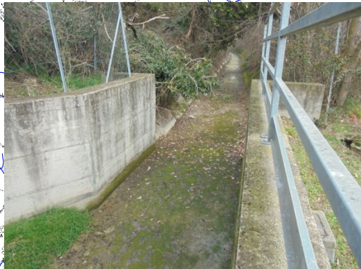
F4 - Sbocco manufatto su canale del Duca con vista dell'inizio del tratto con funzione irrigua, in cui installare un idrometro implementato con scala di deflusso, telecontrollato da remoto per conoscere in tempo reale i valori di portata e volume derivati per uso irriguo.
