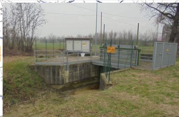
F6 - Sbocco manufatto su canale Canalazzo con vista della paratoia chiusa e del sistema di misura esistente costituito da idrometro con telecontrollo da remoto. Il sistema dovrà essere implementato con una scala di deflusso per conoscere in tempo reale i valori di portata e volume derivati per uso irriguo.
