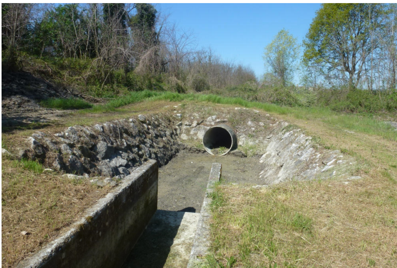
F3 - Vasca di dissipazione da demolire, con Immissione della condotta PRFV di derivazione dal canale del Duca e canaletta di scarico verso il Canalazzo.
