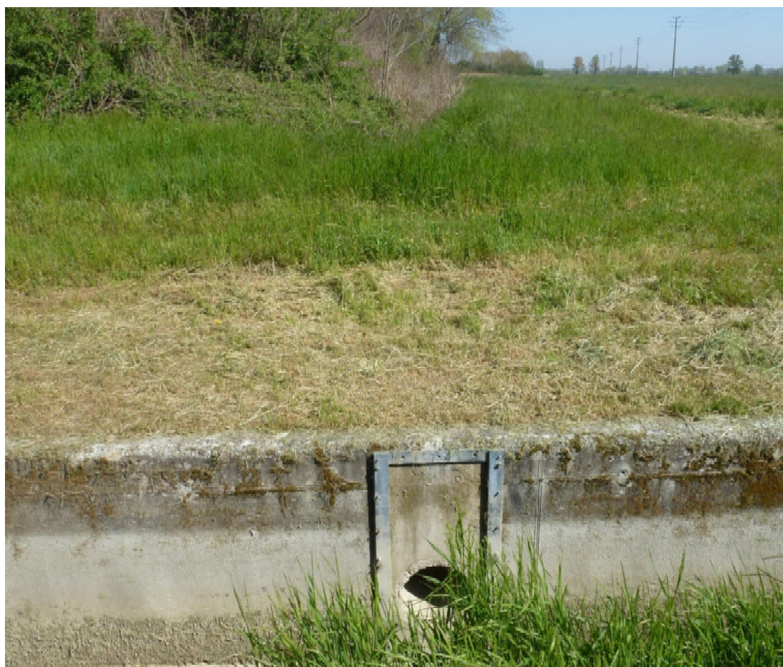
F10 – particolare della paratoia, sulla canaletta a valle della vasca di dissipazione, a favore della derivazione del canale Ariana della Salute in sponda sinistra.
