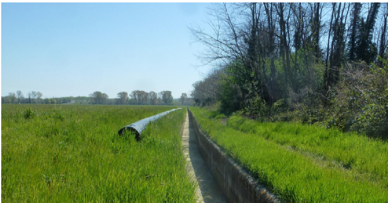
F11 – Canaletta in C.A. di scarico nel Canalazzo a valle della vasca di dissipazione, vista verso valle, in vicinanza all'argine sinistro del rio Campanara. È visibile la tubazione in PEAD DN800 da posare entro la canaletta.
