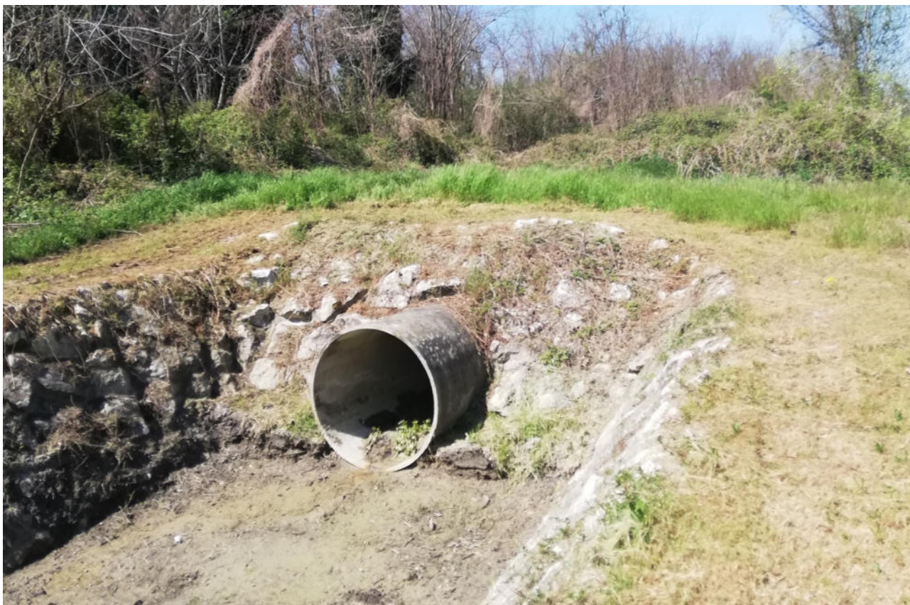
F2 - Immissione della condotta PRFV di derivazione dal canale del Duca nella vasca di dissipazione, dove è prevista la realizzazione del raccordo speciale a tre diramazioni.
