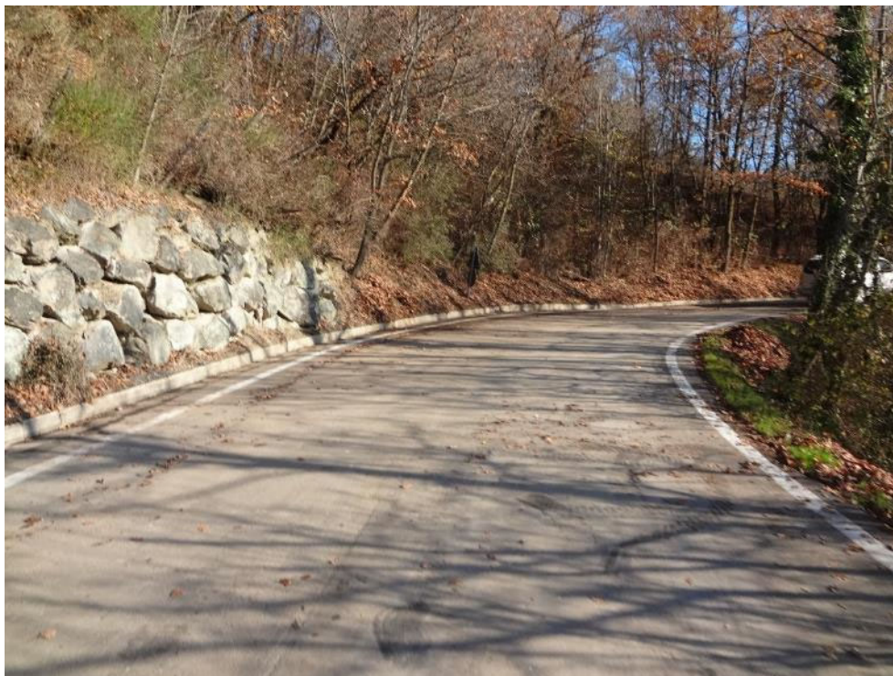
Figura 12: muro di contenimento di monte in massi a secco lungo la Strada Vicinale del Cerreto
