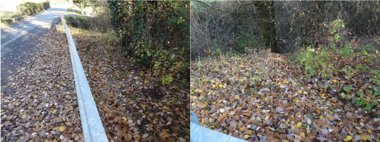
Figura 10: canaletta circolare lungo la Strada Comunale Neviano de' Rossi con scarico a monte del ponte sul Rio Gambiolo
