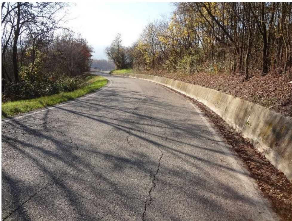
Figura 13: muro di contenimento di monte in cemento armato lungo la Strada Comune di Neviano de' Rossi
