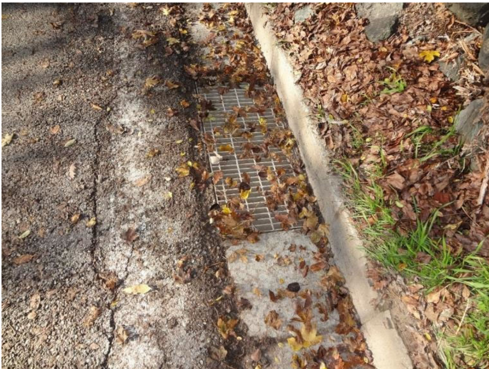
Figura 2: griglia raccolta acque meteoriche lungo la Via Comunale Neviano de' Rossi
