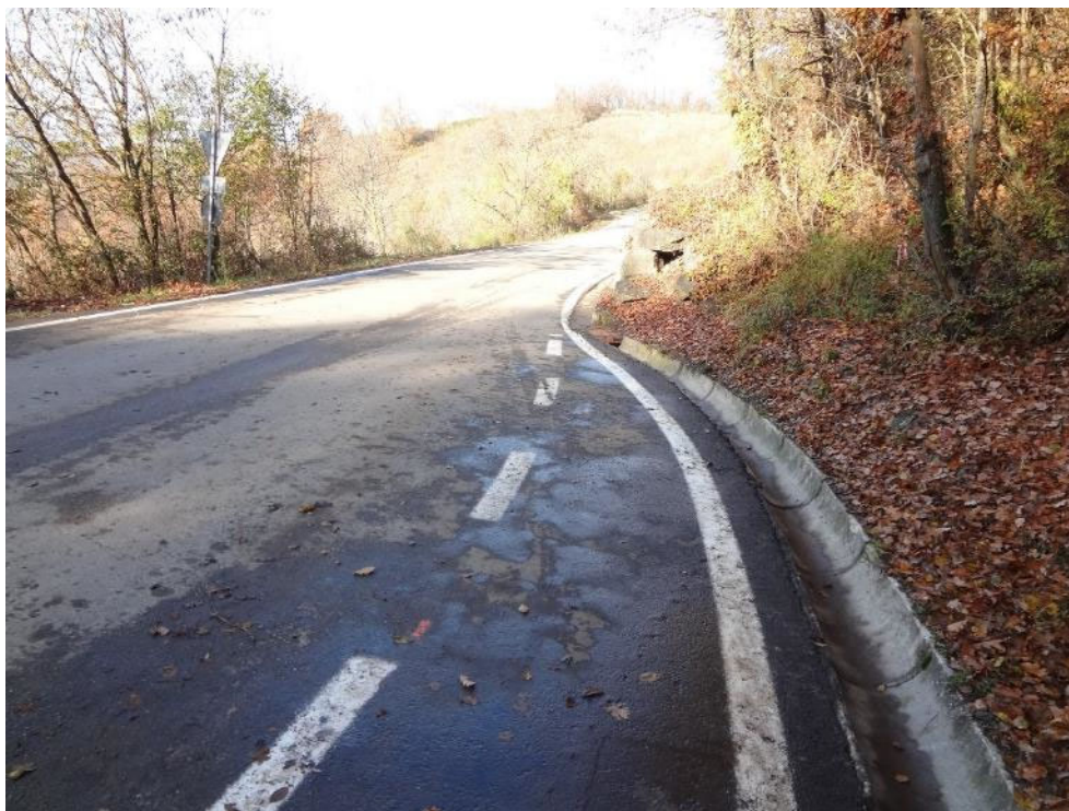
Figura 8: canaletta circolare lungo la Strada Vicinale del Cerreto
