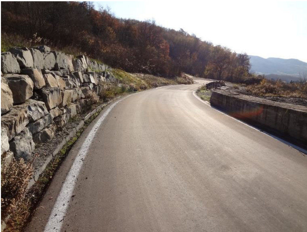
Figura 15: muro di contenimento di monte in massi a secco dissesto n.5 lungo la Strada Vicinale del Cerreto
