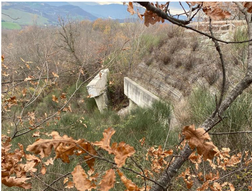
Figura 21: vista strutture di contenimento di valle realizzate nel 2011 presso dissesto n.6 lungo la Strada Vicinale del Cerreto
