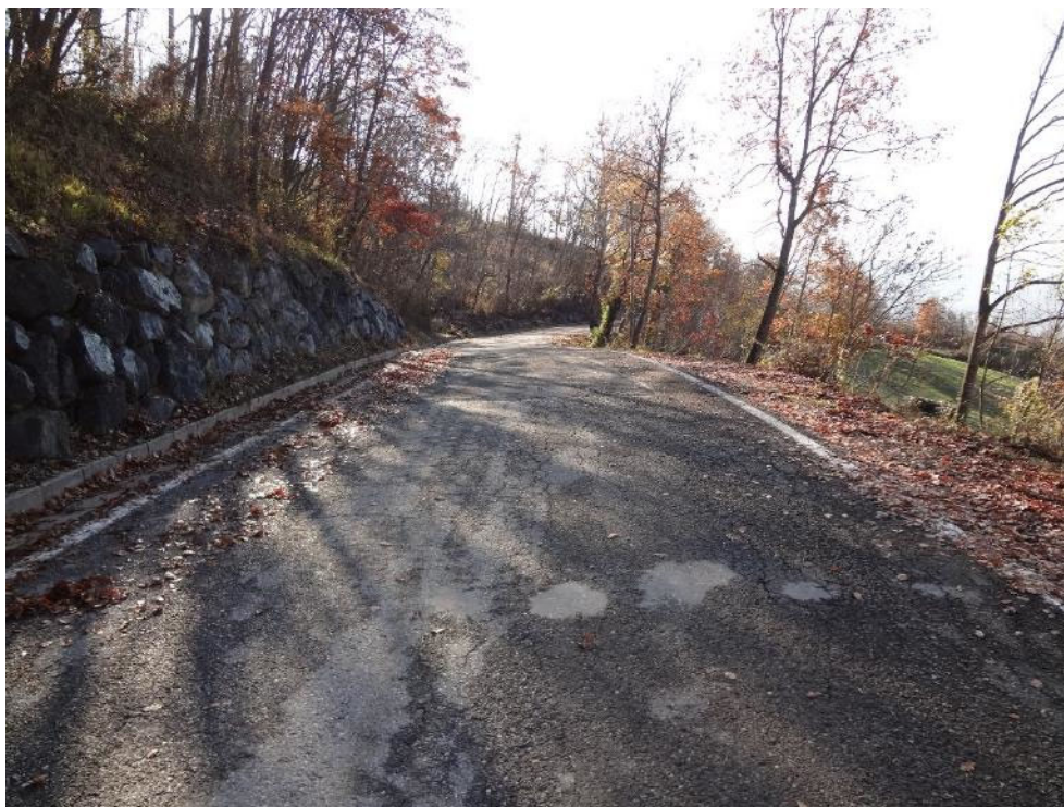
Figura 11: muro di contenimento di monte in massi a secco lungo la Strada Vicinale del Rico Riccò
