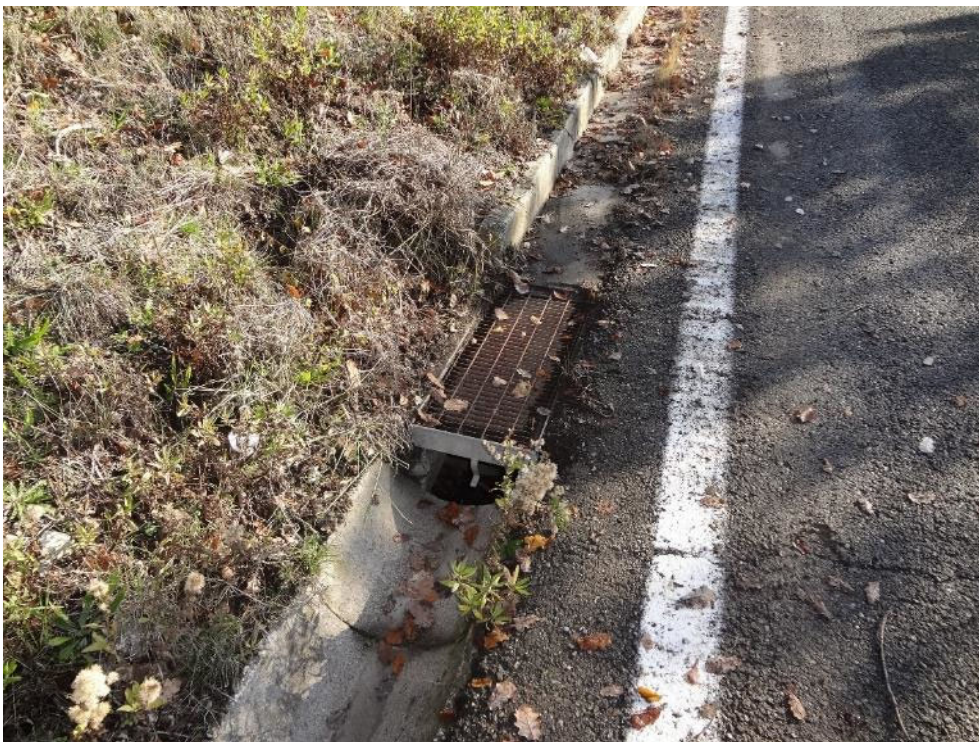
Figura 6: griglia raccolta acque meteoriche lungo la Strada Vicinale del Rio Riccò
