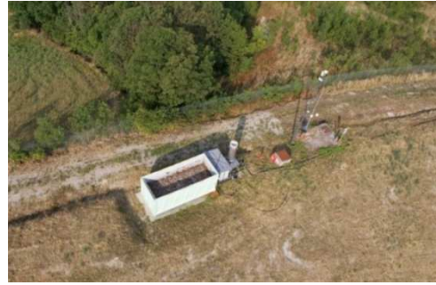
Biofiltro con Torcia e Stazione meteo esistenti
