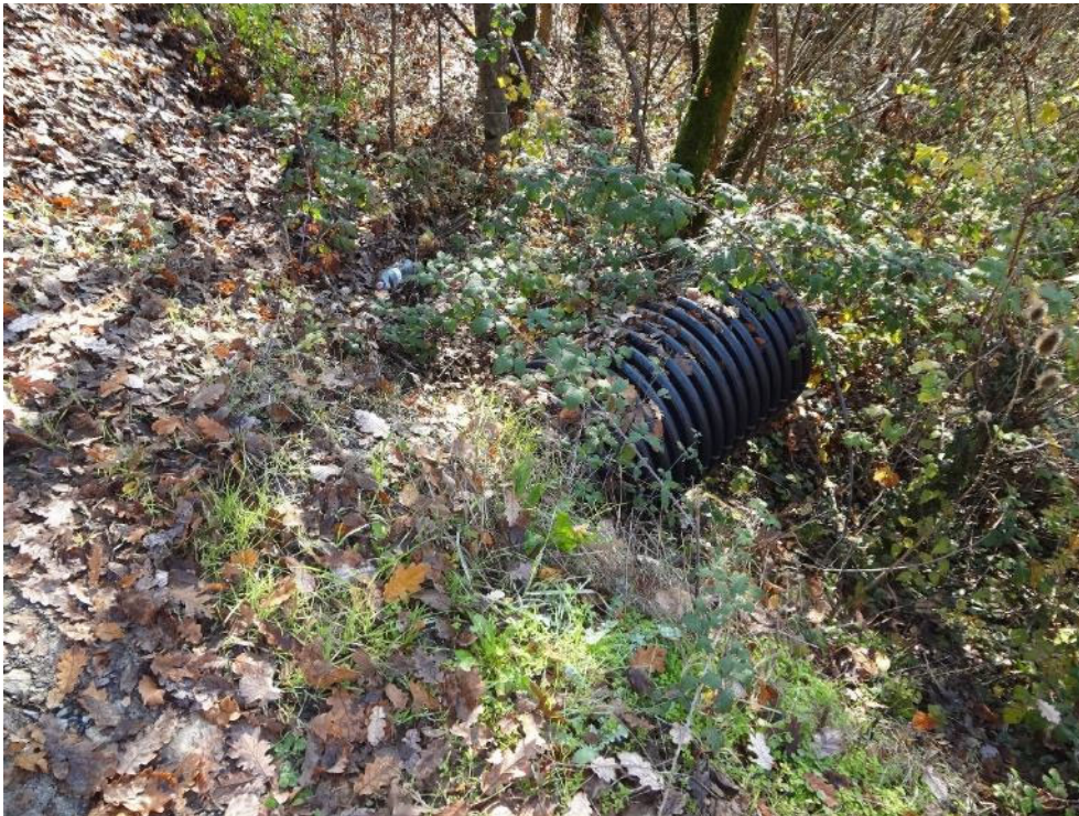
Figura 5: terminale tubazione di scarico acque meteoriche a valle carreggiata lungo la Strada Vicinale del Cerreto
