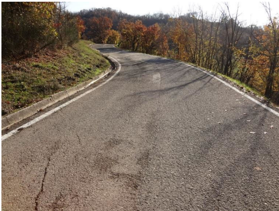
Figura 9: canaletta circolare lungo la Strada Vicinale del Rio Riccò
