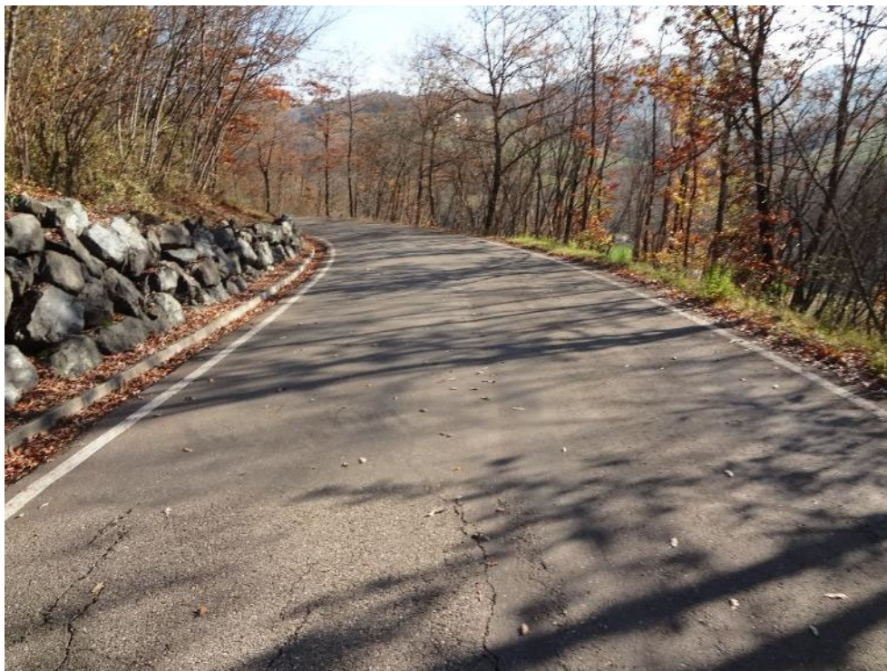
Figura 14: muro di contenimento di monte in massi a secco lungo la Strada Comune di Neviano de' Rossi
