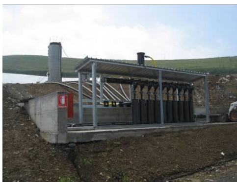
Foto 1 : Stazione di regolazione del biogas
