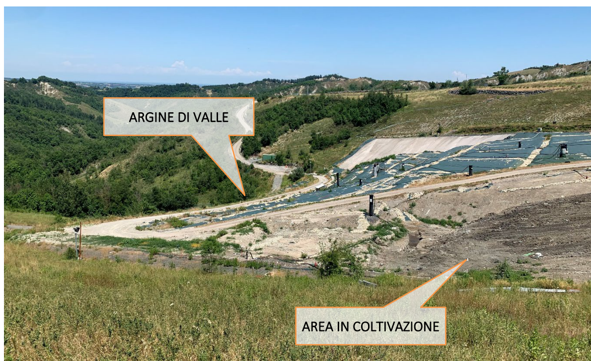
Figura 3.12: FOTO 03 - Vista da Ovest della porzione di valle del corpo rifiuti – In primo piano la porzione in fase di coltivazione
