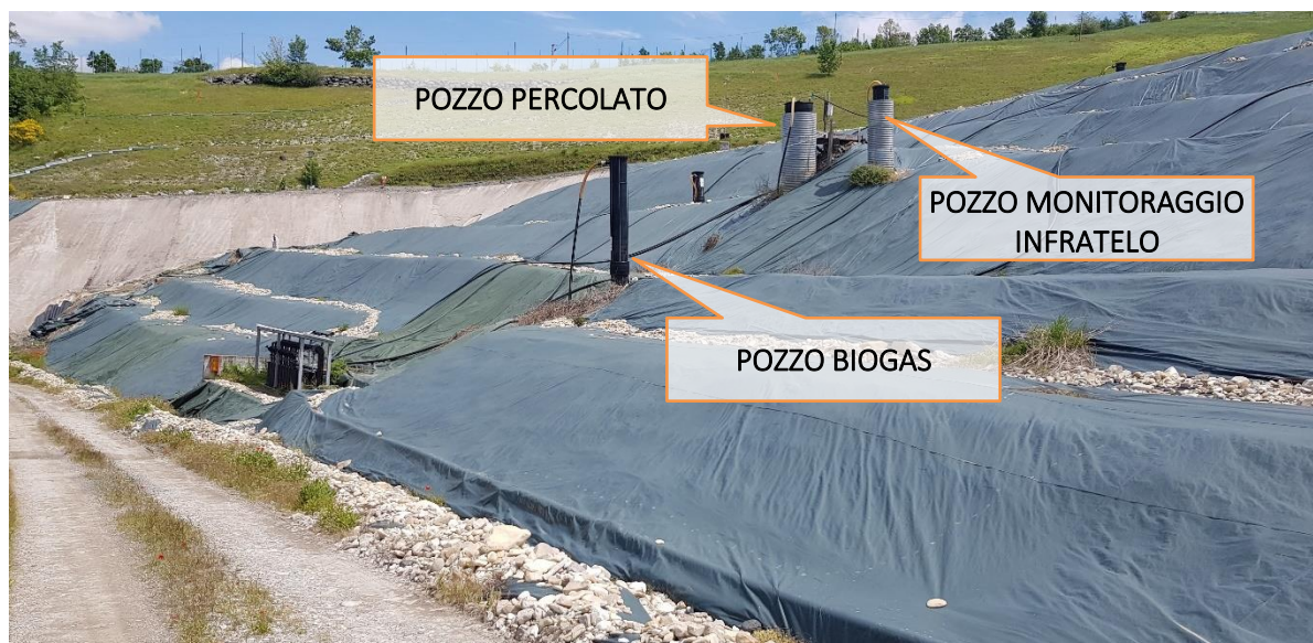
Figura 3.14: FOTO 05 - Vista da Nord-Ovest del corpo rifiuti - Particolare della gradonatura a monte dell'argine e dei sistemi di estrazione del percolato e del biogas.
