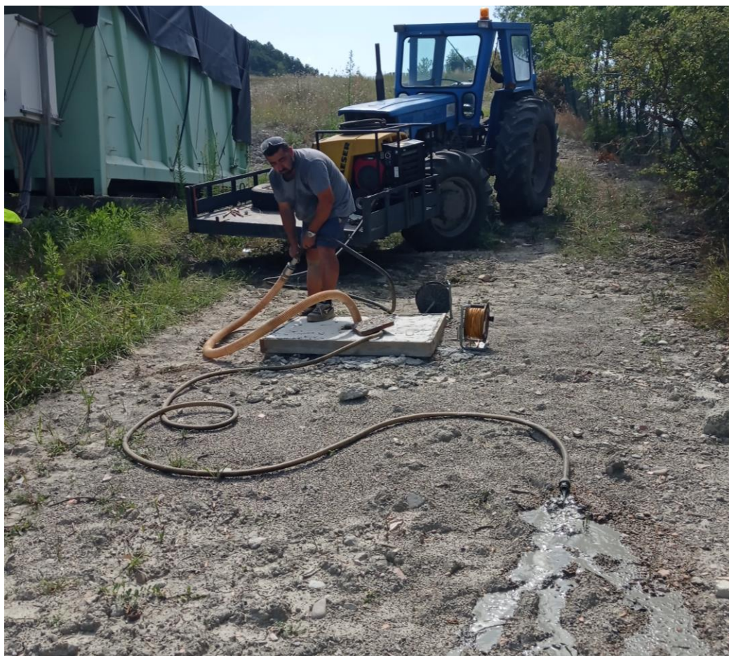
Fig. 4 - Particolare durante l'esecuzione dello spurgo.
