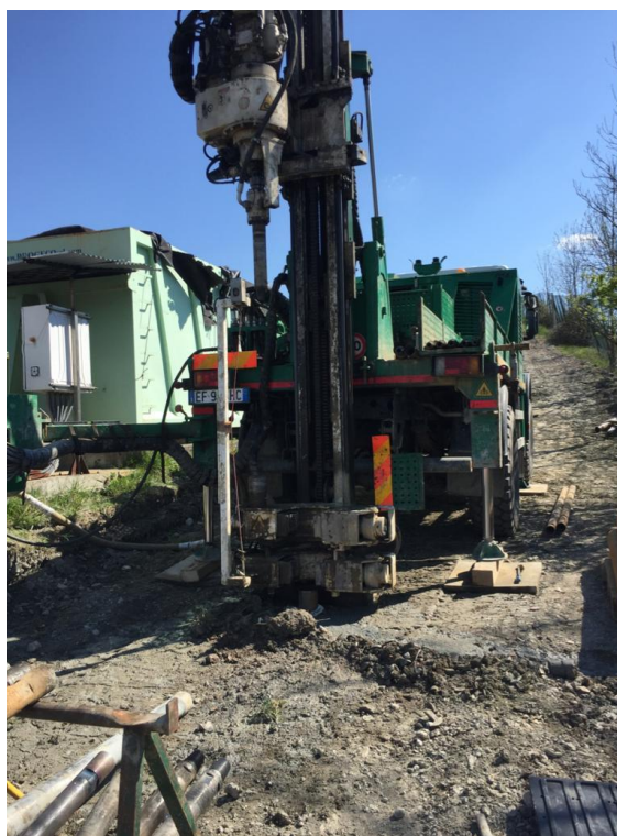
Fig. 5 - Particolare della sonda durante la perforazione SE 01
