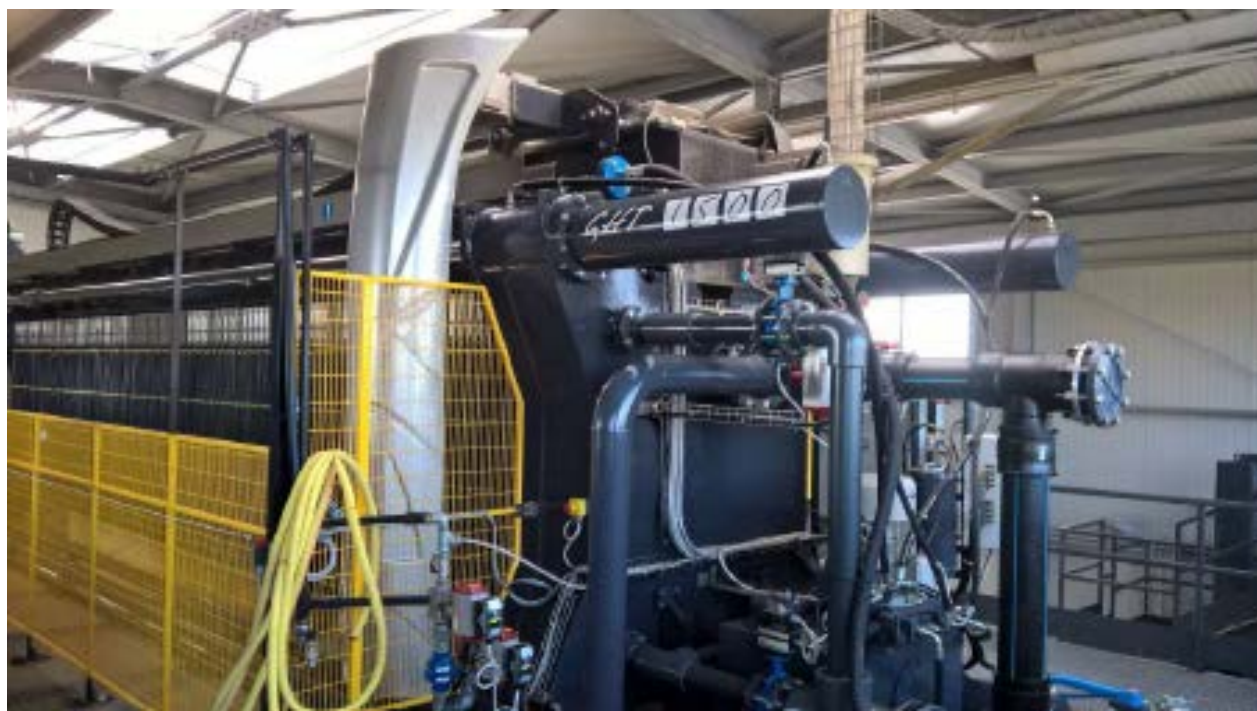
Figura 12 Dettaglio della sorgente S3: la nuova filtropressa GHT 1500.
