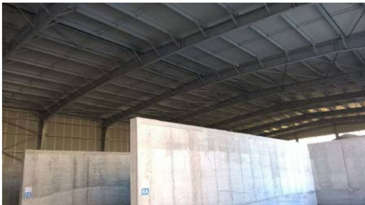
Figura 7 La sorgente S5 (fabbricato baie stoccaggio inerti) visto dall'interno. Notare sul fondo la parete di tamponamento lato est costituita pannelli sandwich fonoisolanti e fonoassorbenti, microforati sul lato interno.
