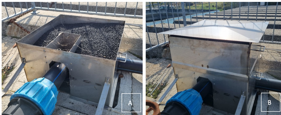
Figura 2.12: filtro a carboni attivi a presidio dello sfiato dell'attuale vasca percolato. Foto A: senza cappellotto protettivo, vista su letto di carboni attivi; Foto B: configurazione operativa con cappellotto protettivo.
