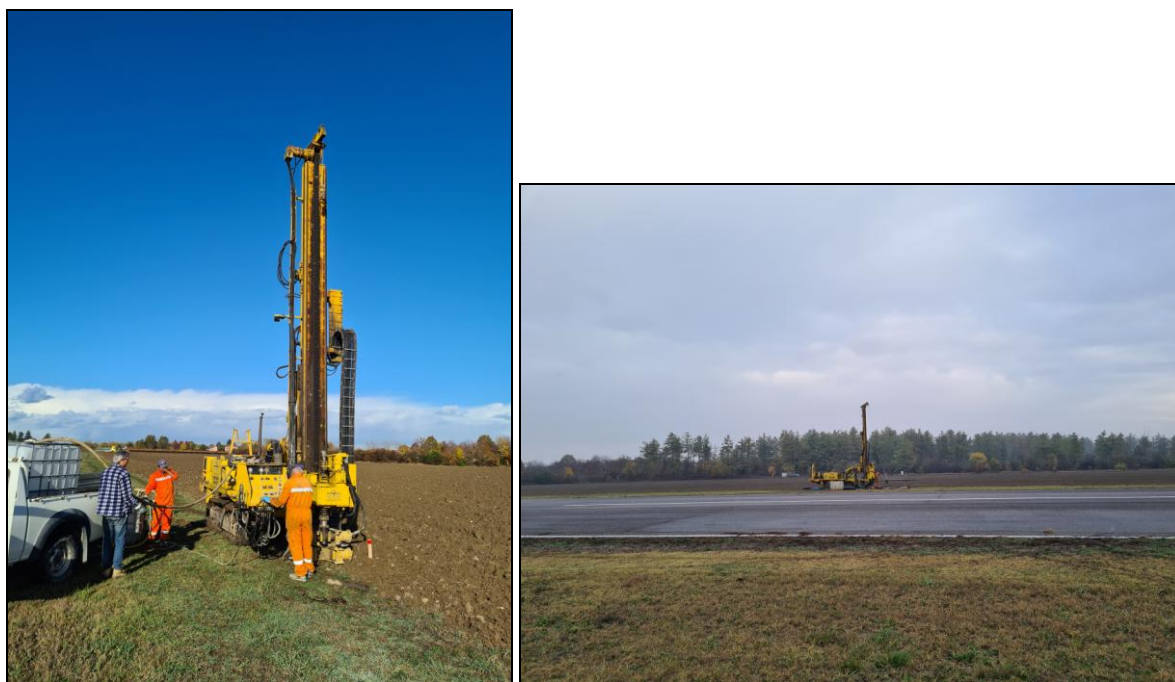
Figura 2.2 – Ripresa fotografica delle operazioni di perforazione del Pm3
