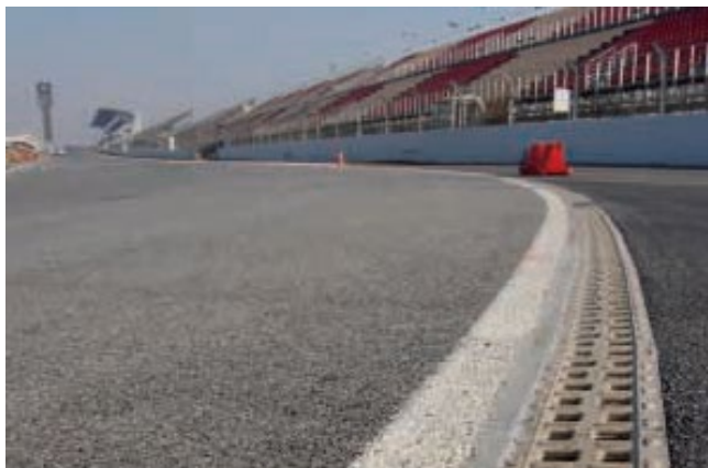
Figura-18: Il sistema Monoblock per il drenaggio della pista
