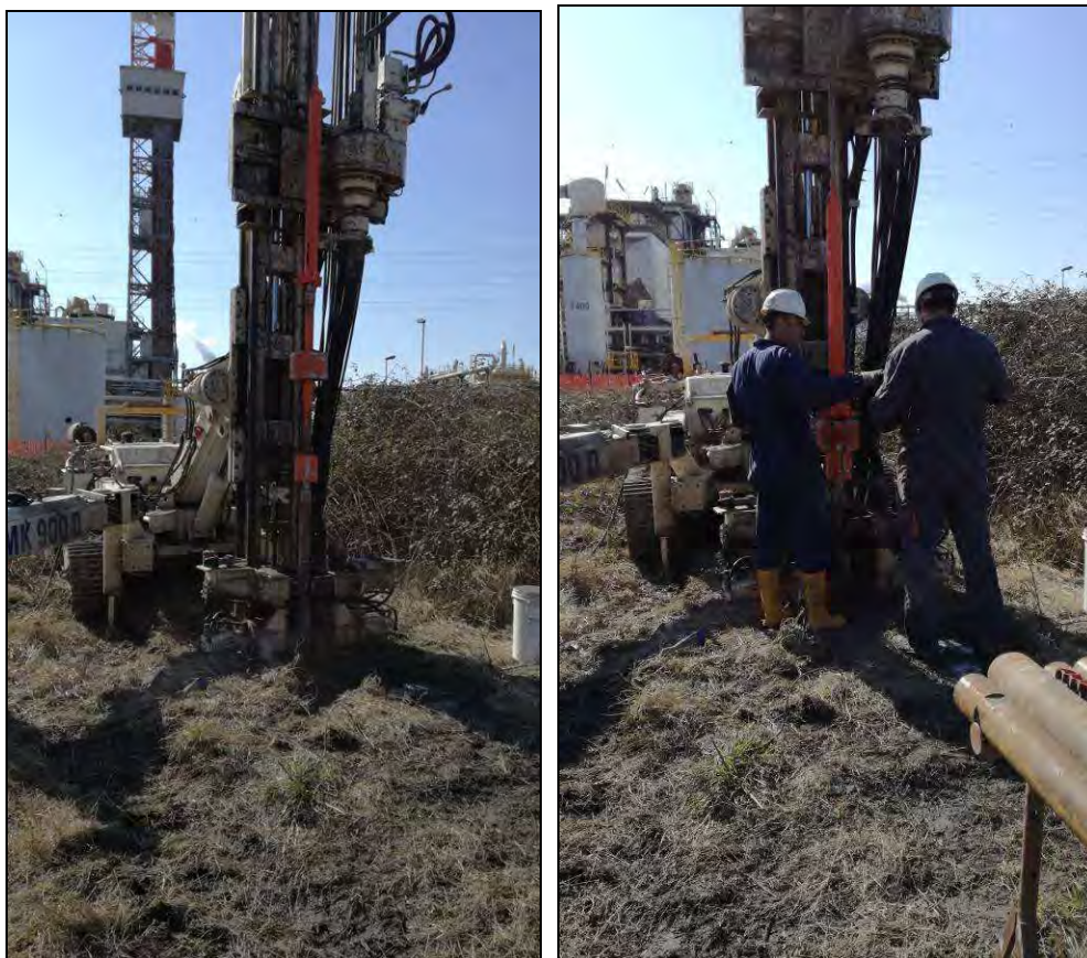
Fig. 9. Esecuzione prove SPT durante il sondaggio BH-01
