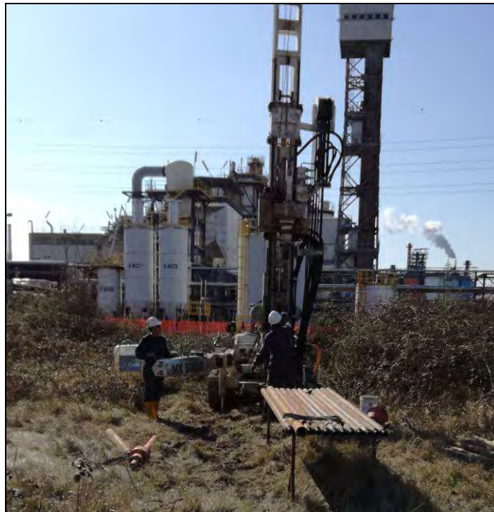
Fig. 1. Posizionamento ed esecuzione del sondaggio BH-01 con sonda Gaia.
