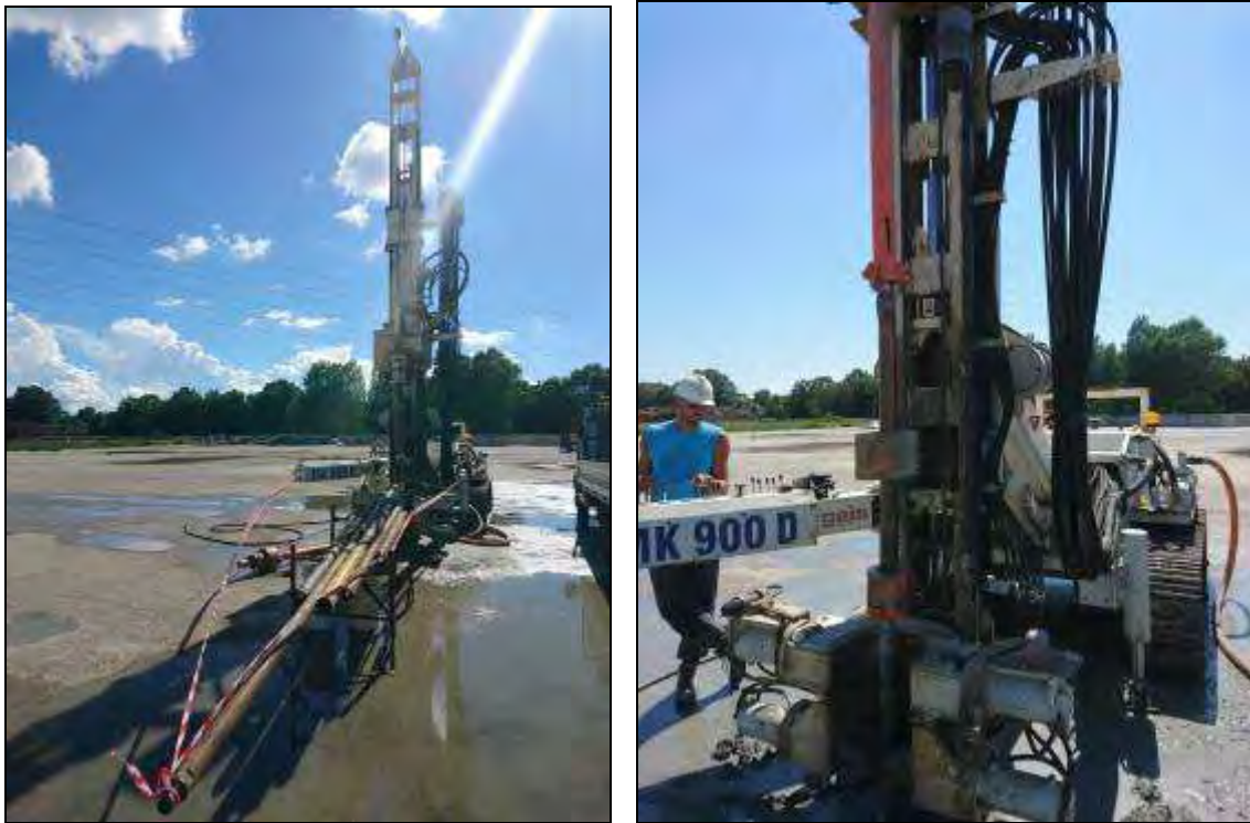
Fig.9. Posizionamento ed esecuzione del sondaggio S02 con sonda Gaia.
