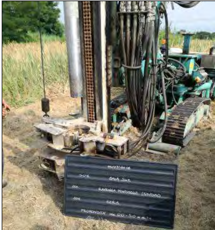
Fig. 2. Posizionamento ed esecuzione del sondaggio S01 con sonda Gaia.
