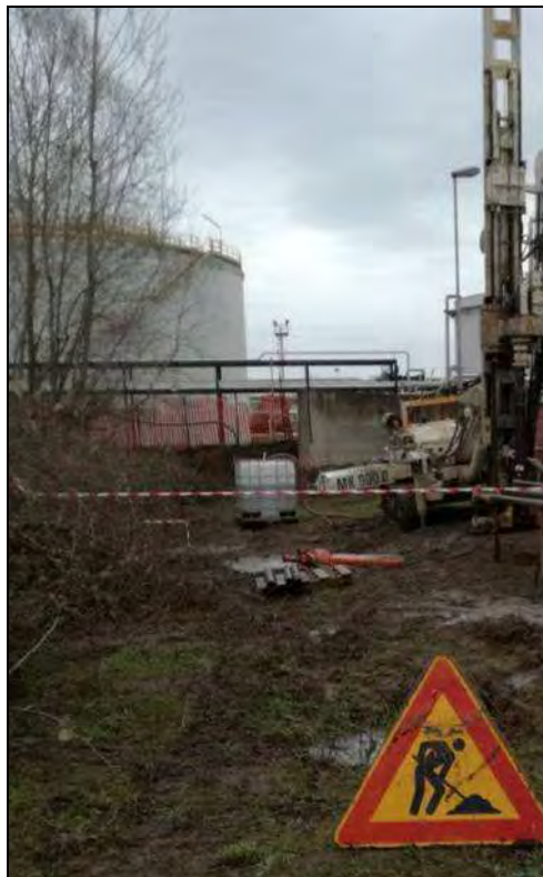
Fig.20. Posizionamento ed esecuzione del sondaggio BH-03 con sonda Gaia.
