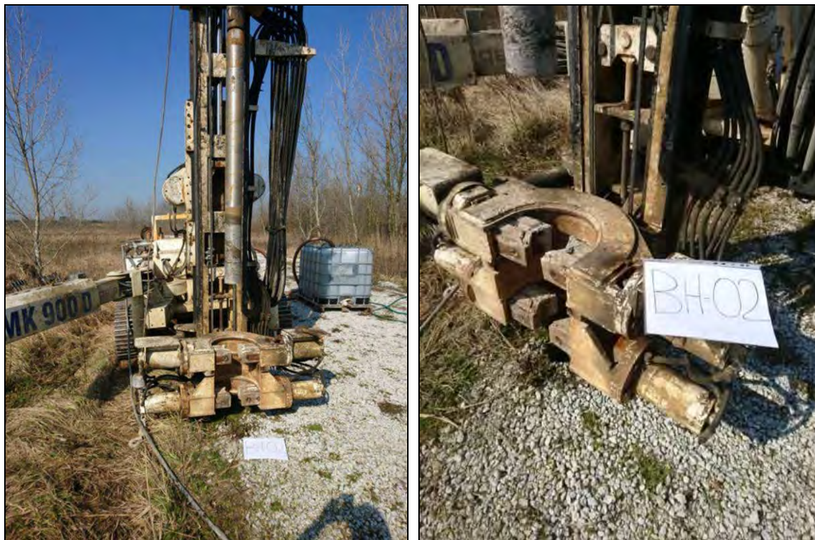
Fig.10. Posizionamento ed esecuzione del sondaggio BH-02 con sonda Gaia.
