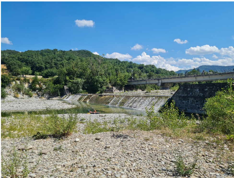
Figura 34 – Briglia esistente e ponte strada comunale per Cedogno, vista da valle.
