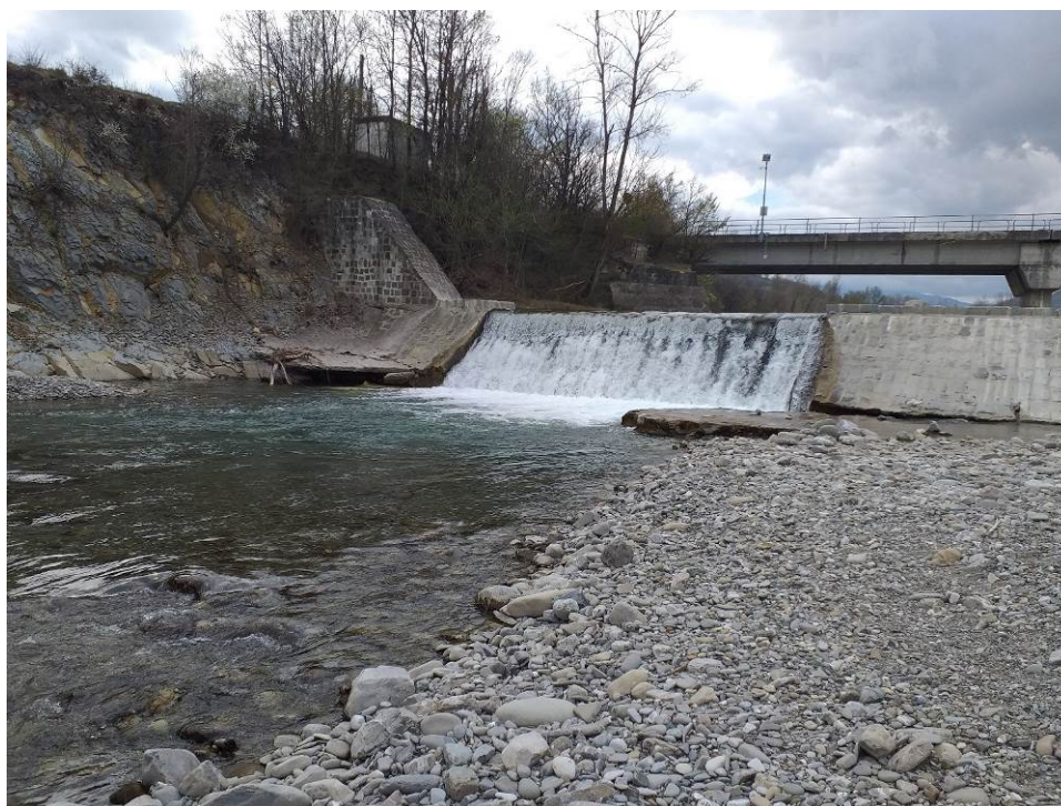
Figura 37– Particolare briglia esistente, vista da valle (destra idraulica).
