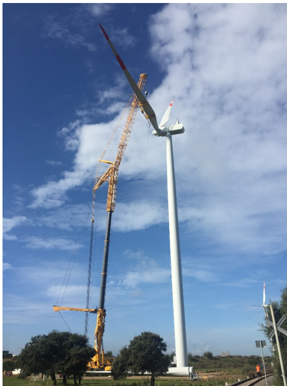
Fig. 18: montaggio pale
