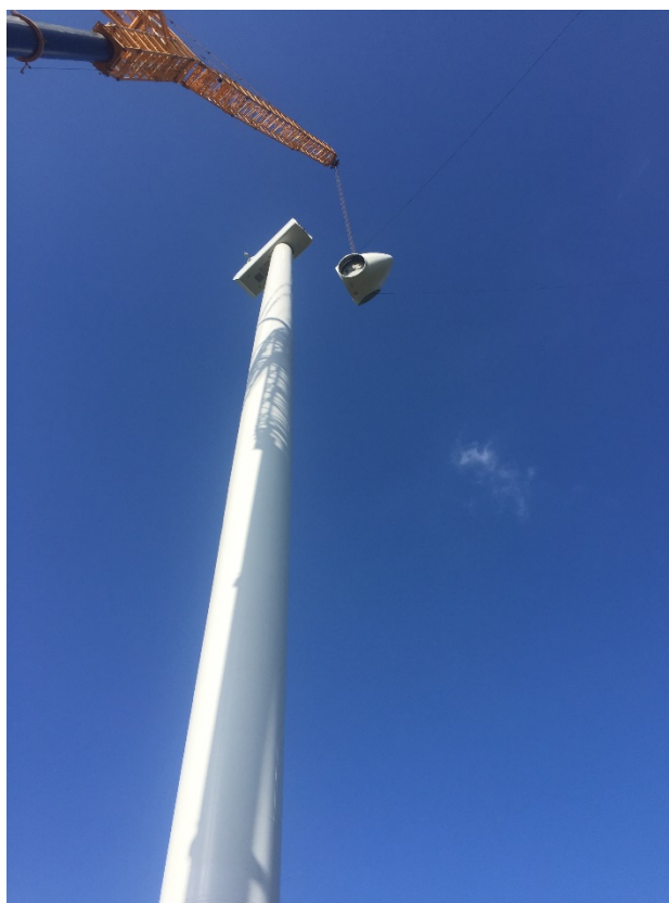
Figura 17: montaggio supporto rotore (hub)
