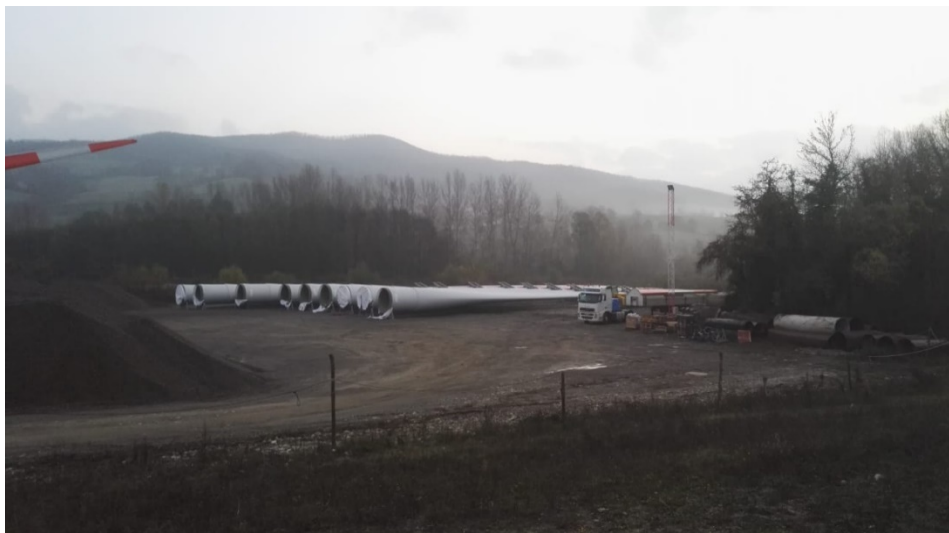
Figura 12: stoccaggio temporaneo pale nell'area di trasbordo
