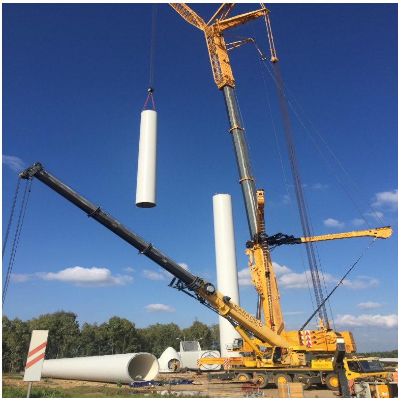
Figura 16: montaggio tronco di torre intermedio
