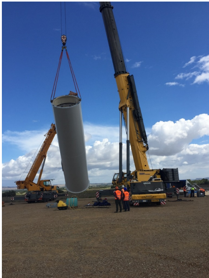
Figura 14: sollevamento primo tronco di torre (bottom) su dado fondazione
