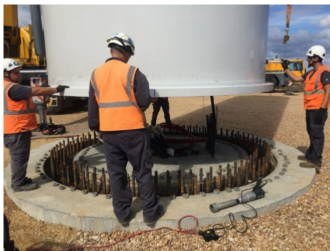
Fig. 15: preparazione montaggio primo tronco di torre (bottom) su dado fondazione
