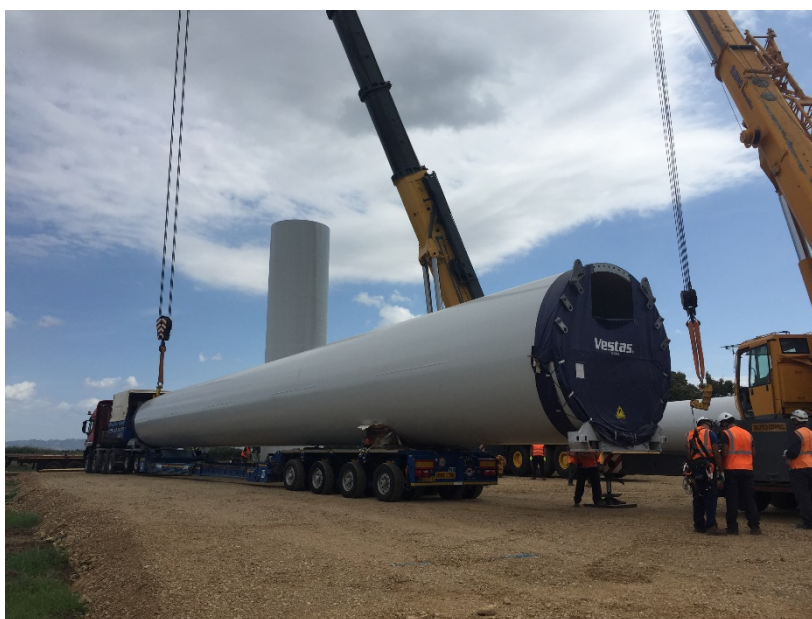
Fig. 13: scarico di tronco di torre
