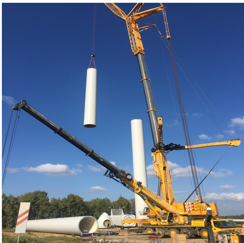
Fig. 16: montaggio tronco di torre intermedio
