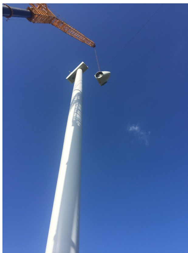
Fig. 17: montaggio supporto rotore (hub)
