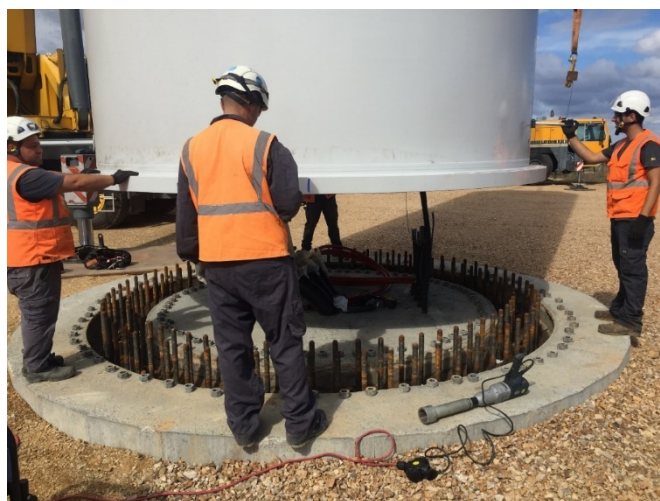
Figura 15: preparazione montaggio primo tronco di torre (bottom) su dado fondazione
