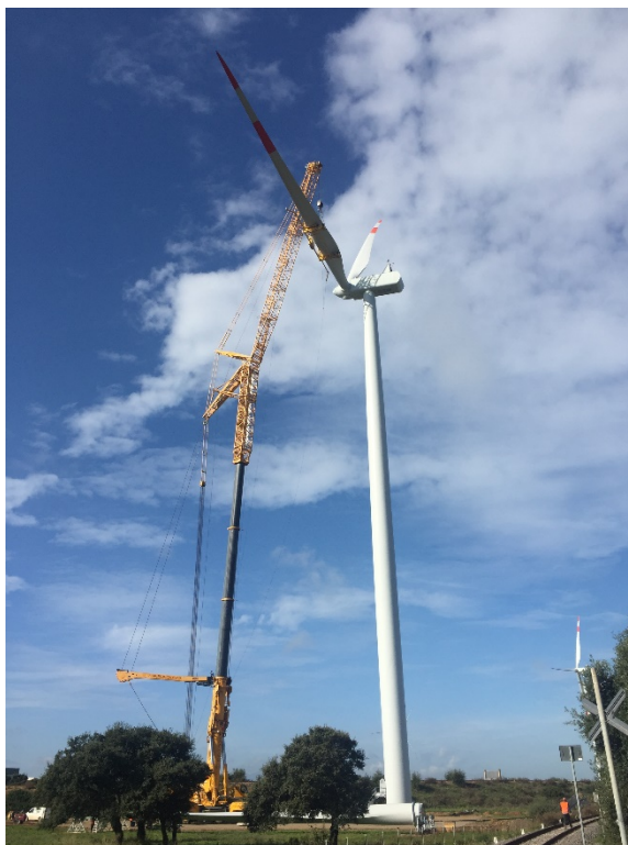
Figura 18: montaggio pale
