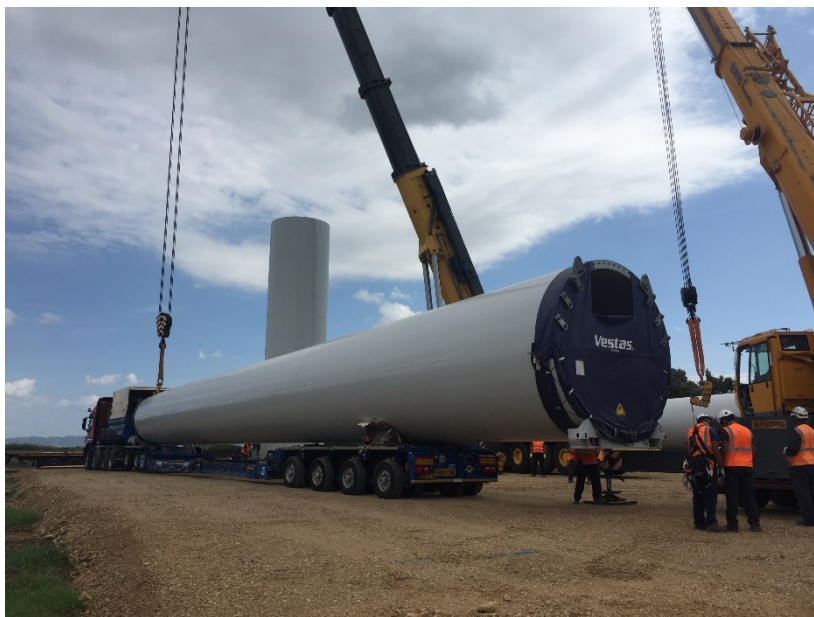
Figura 13: scarico di tronco di torre
