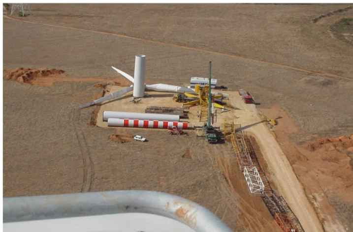
Figura 20 – Piazzola per il montaggio dell'aerogeneratore
