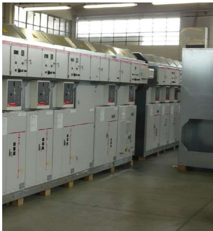
Figura 10 Esempio di quadri di raccolta cavi a 30KV, da interno.
