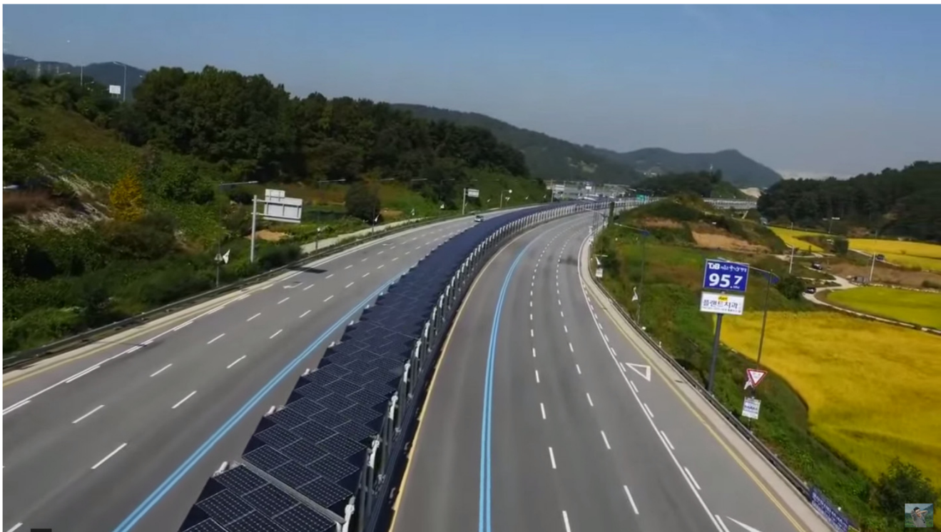
Figura 4: Pista ciclabile alimentata ad energia solare costruita al centro dell'autostrada che collega Daejeon e Sejong
