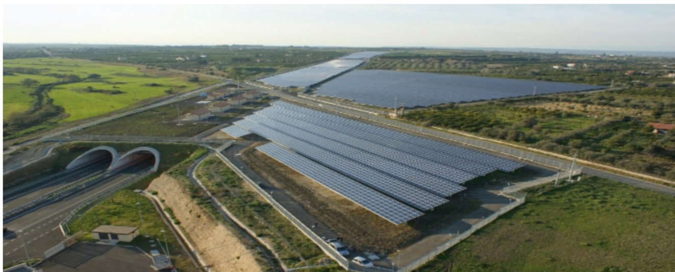
Figura 2: Impianto fotovoltaico a terra ubicato al di sopra delle gallerie artificiali dell'Autostrada Catania-Siracusa
