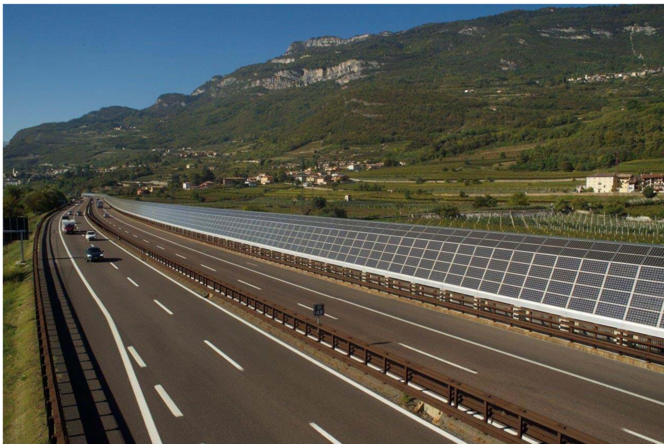
Figura 3: Moduli fotovoltaici installati su una barriera antirumore e fonoassorbente da Autostrada del Brennero
