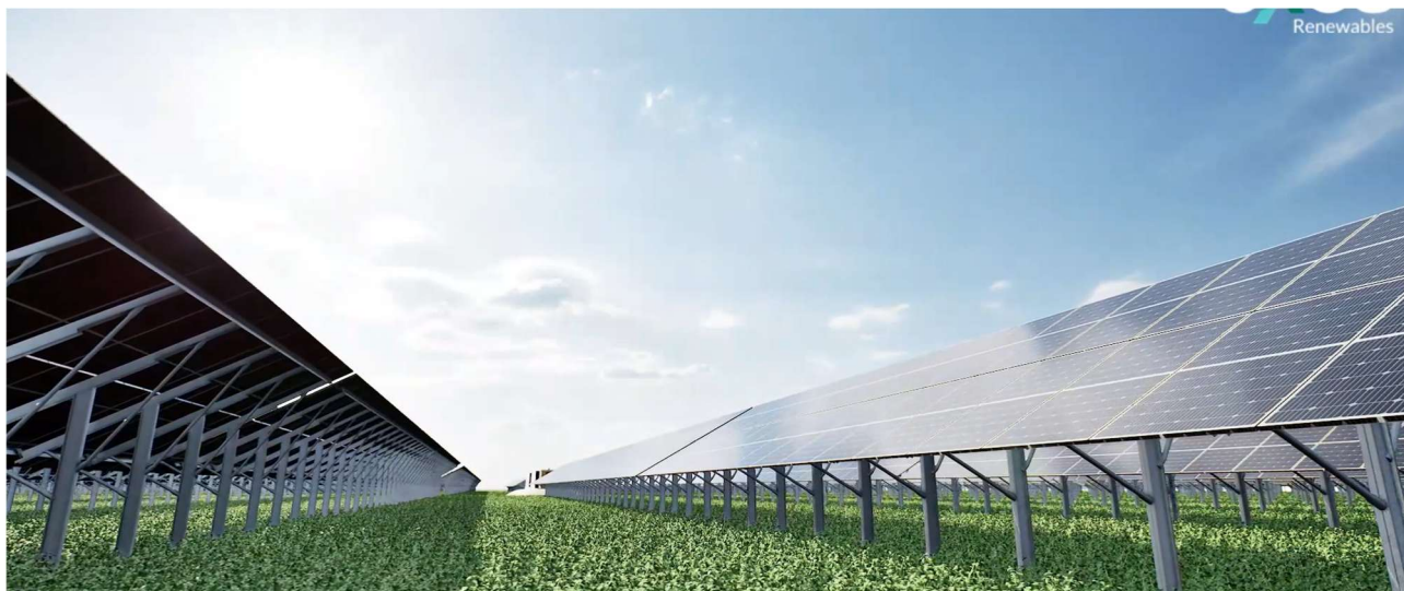
Figura 3-2: Struttura di sostegno dei moduli fotovoltaici
