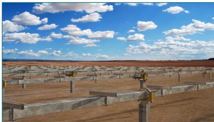
Figura 6 - Tipico di installazione 1P: particolari strutture di sostegno e moduli
