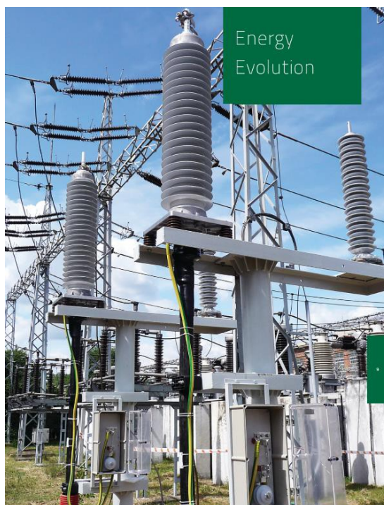
Figura 15 - Terminali cavo
