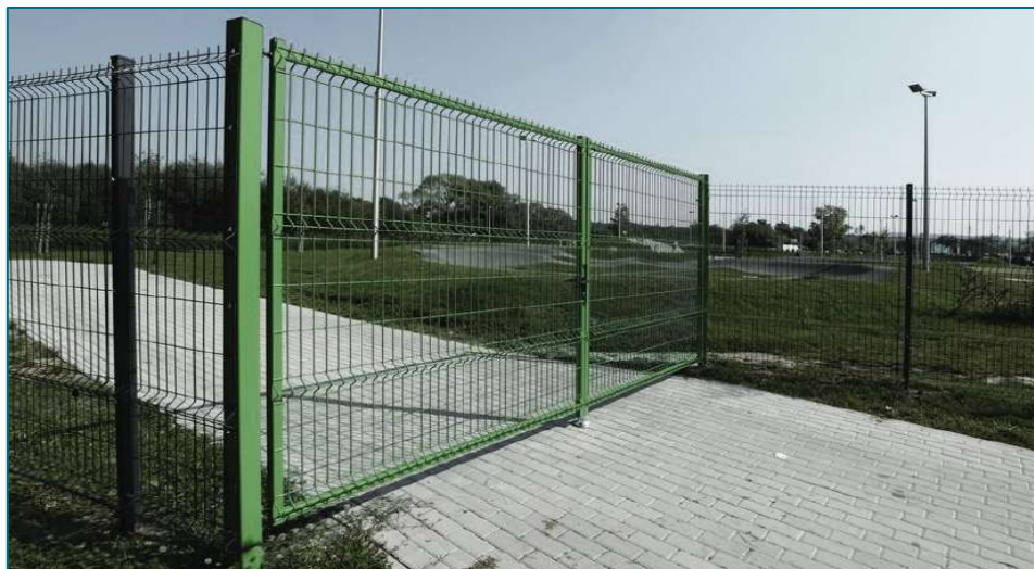
Figura 3 - Tipico di cancello a doppia anta per accesso ai sottocampi
