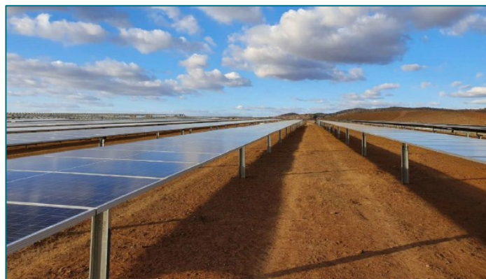
Figura 6 - Tipico di installazione 1P: particolari strutture di sostegno e moduli
