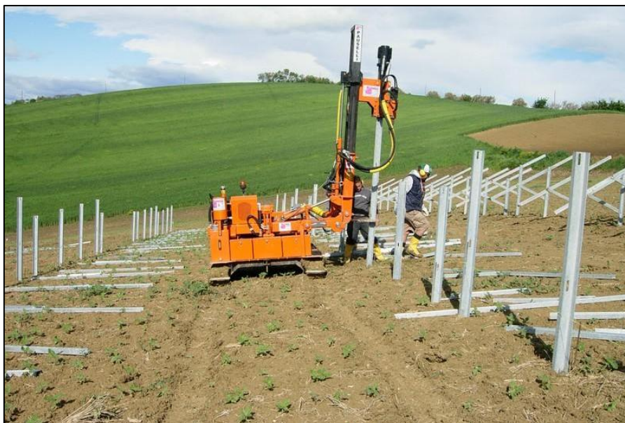
Figura 11 – Esempio di macchina battipalo e installazione con pali infissi (fonte: Pauselli group)
